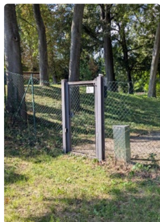
Uno degli ingressi lungo la recinzione che verranno rimossi
