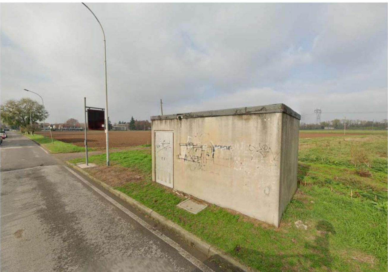
Foto 3 - Fermata bus e cabina elettrica
