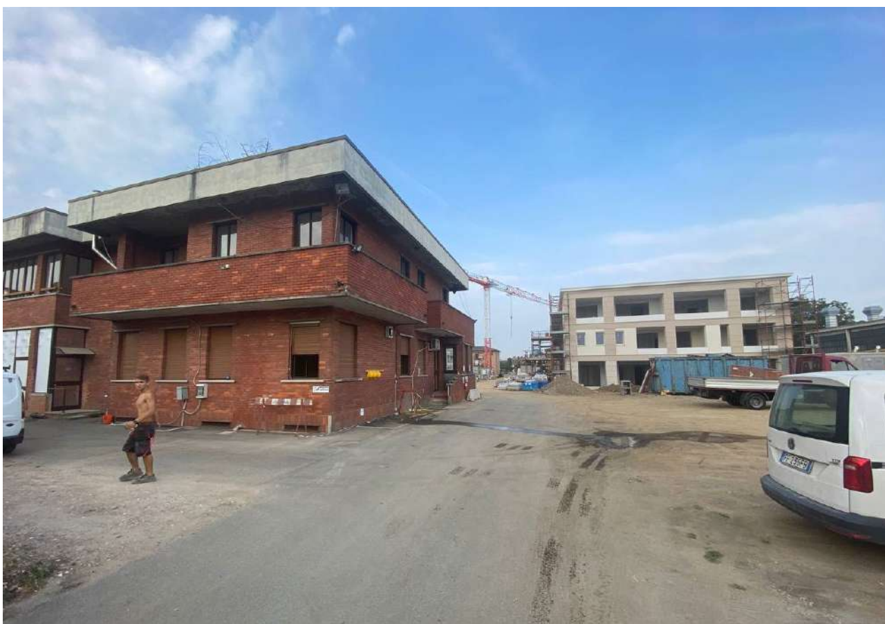
Foto n° 5 - 6 ( Spazi Interni - Aree oggetto di Valutazione )
