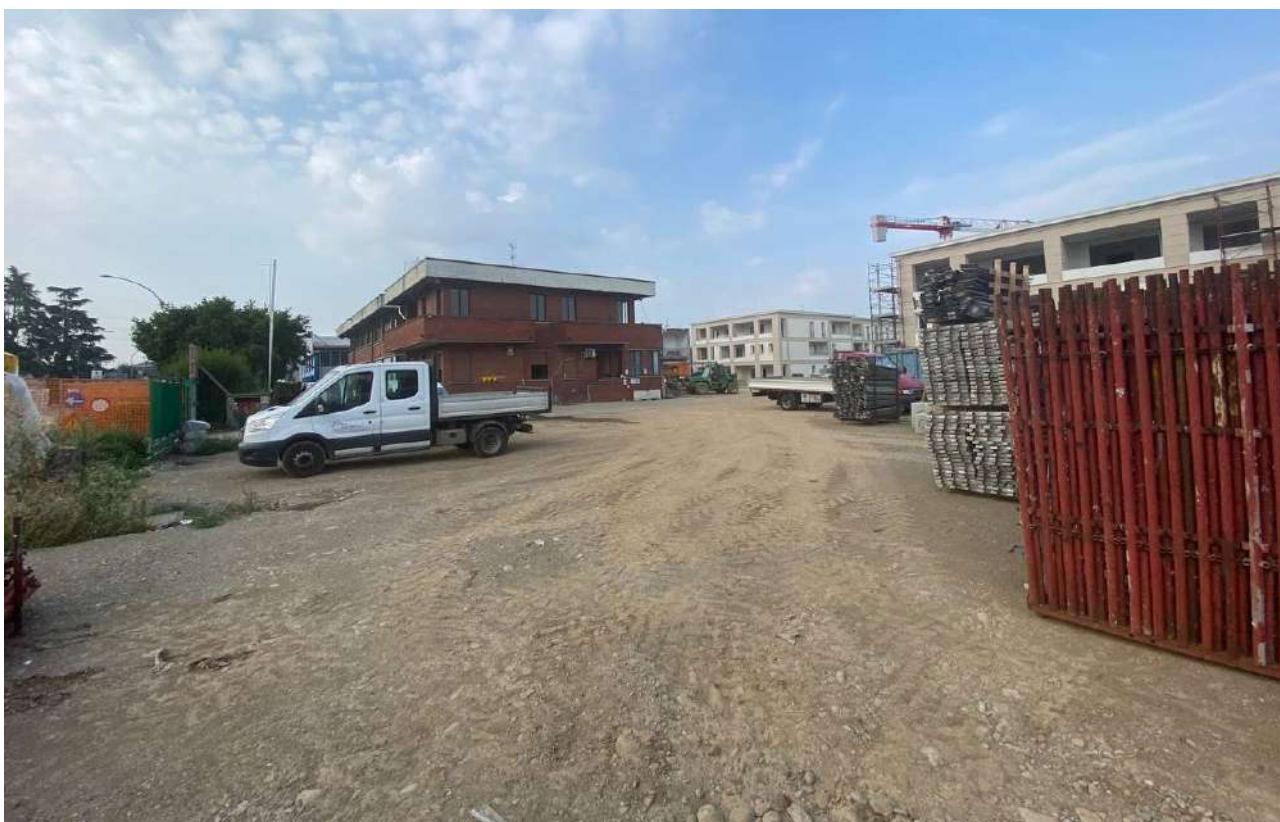
Foto n° 7 - 8 ( Spazi Interni - Aree oggetto di Valutazione )
