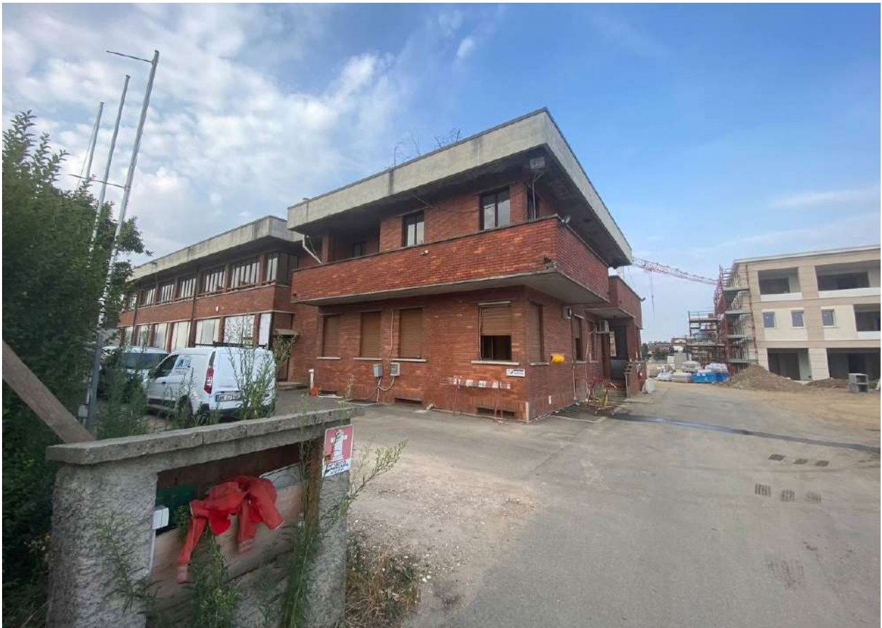
Foto n° 3 - 4 ( Ingresso al Cantiere )
