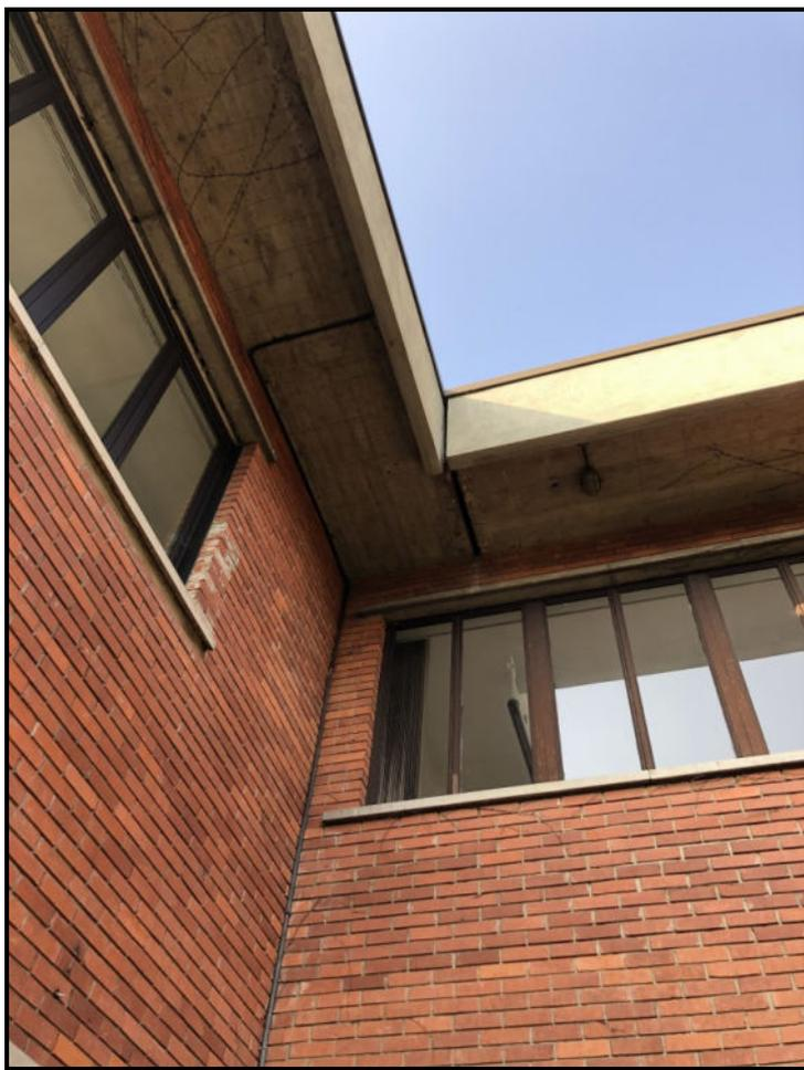
FOTO 10 – Particolare giunto strutturale (zona anteriore)
