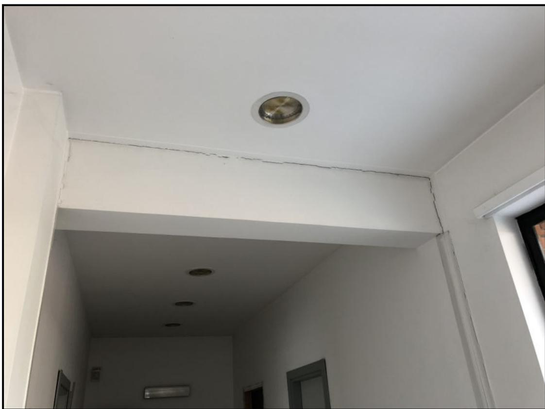
FOTO 23 – Particolare giunto strutturale piano primo
