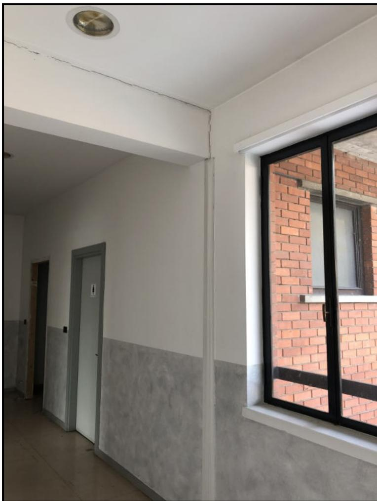
FOTO 22 – Particolare giunto strutturale piano primo
