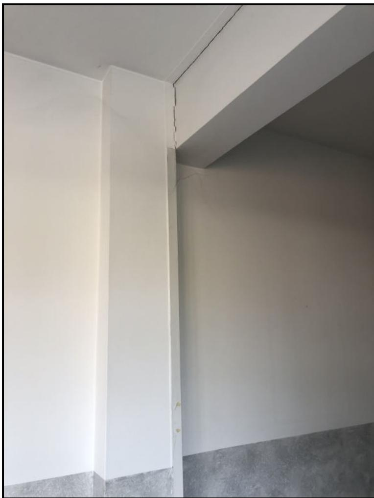
FOTO 24 – Particolare giunto strutturale piano primo
