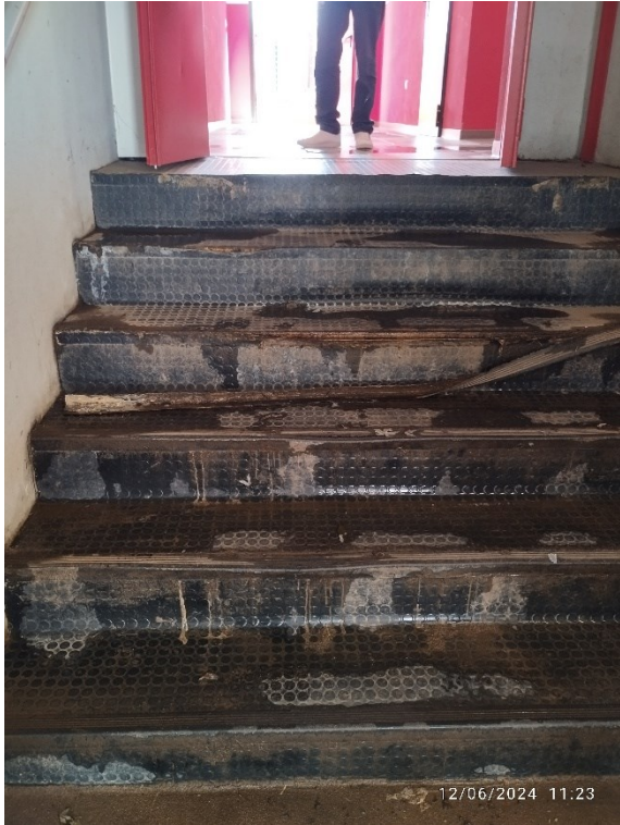
Allagamento per tracimazione dal campo al passaggio interno dalle scale e presenza acqua sul pavimento Foto del 11/07/24
