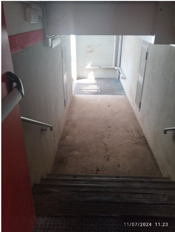
Allagamento per tracimazione dal campo al passaggio interno dalle scale e presenza acqua sul pavimento Foto del 11/07/24
