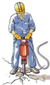
Qualora non sia possibile evitare l'utilizzo diretto di utensili ed attrezzature comunque capaci di trasmettere vibrazioni al corpo dell'operatore, queste ultime devono essere dotate di tutte le soluzioni tecniche più efficaci per la protezione dei lavoratori (es.: manici antivibrazioni, dispositivi di smorzamento, etc.) ed essere mantenute in stato di perfetta efficienza. Ogni qualvolta vengono utilizzate attrezzature che producono vibrazioni al sistema mano-braccio, quali:
