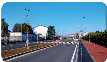
Sono stati completati i lavori relativi alla via Masaccio, con la fine anche dell'ultimo passaggio mancante, relativo alla tintura con vernice rossa della pista ciclabile. Ultimati anche i lavori sulla rotatoria di via Torino, all'incrocio con via Brescia: l'asfalto depositato provvisoriamente, sarà sostituito con quello definitivo con l'arrivo delle temperature più miti della primavera.
