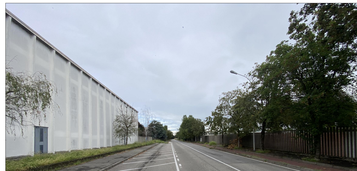
FOTO DELLO STATO DI FATTO 02 - Via. G. Di Vittorio
