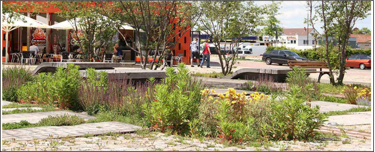
Trincea drenante vegetata a Zollhallen Plaza, piazza inondabile realizzata in quartiere periferico di Friburgo, in Germania. (Progetto di Ramboll Studio Dreiseitl, foto di B.Doherty)
