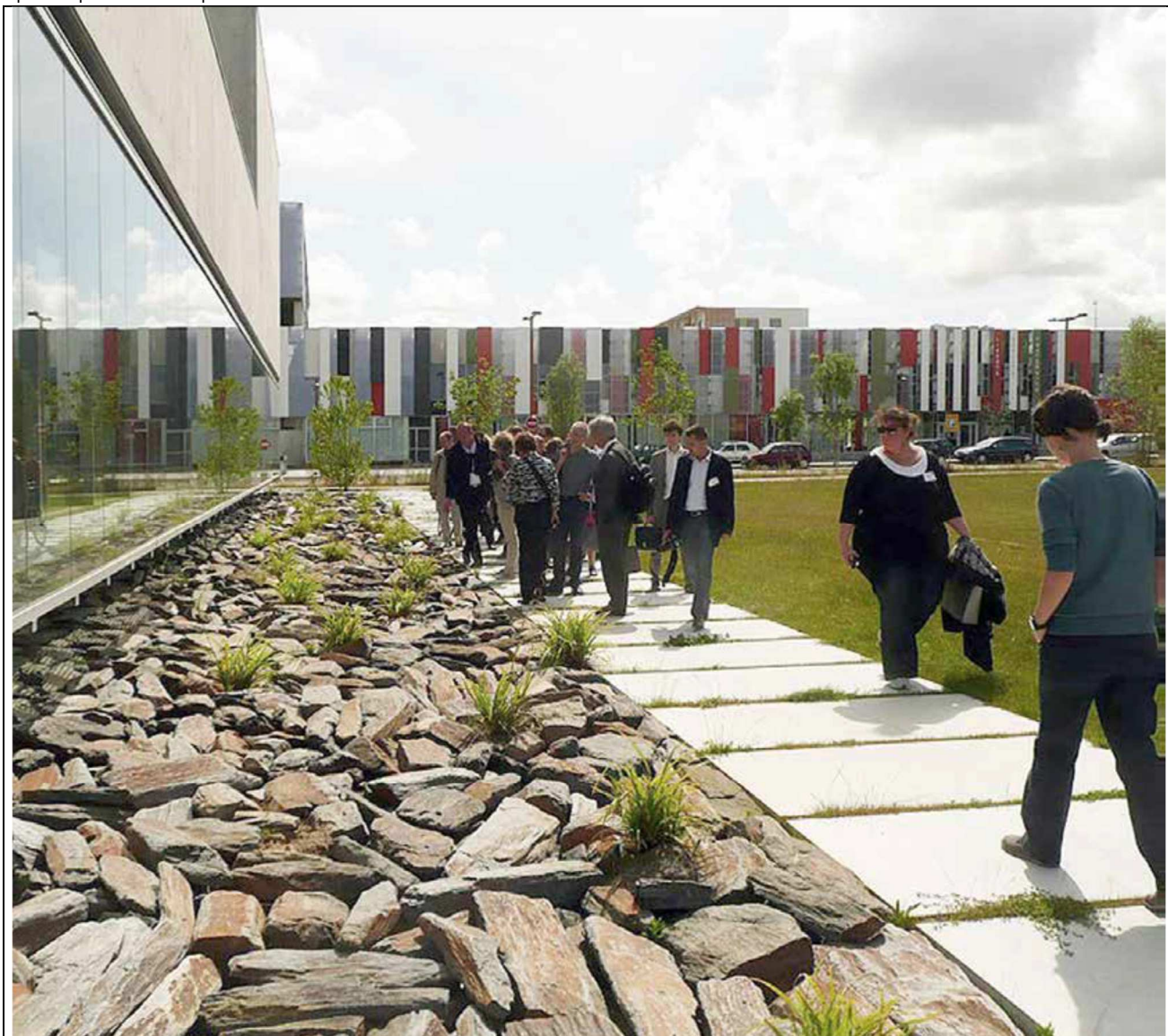
Trincea drenante a margine della biblioteca pubblica dell'eco-quartiere Bottière Chêne a Nantes, in Francia. (Progetto paesaggistico e foto di Atelier de Paysage Bruel-Delmar)
