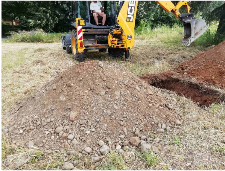
Foto 3: Ubicazione Trincea S2
