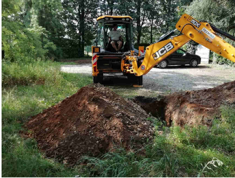
Foto 5: Ubicazione Trincea S3
