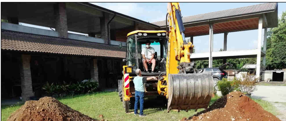
Figura 9: Edificio sud oggetto di riqualificazione (vista verso sud-ovest)
