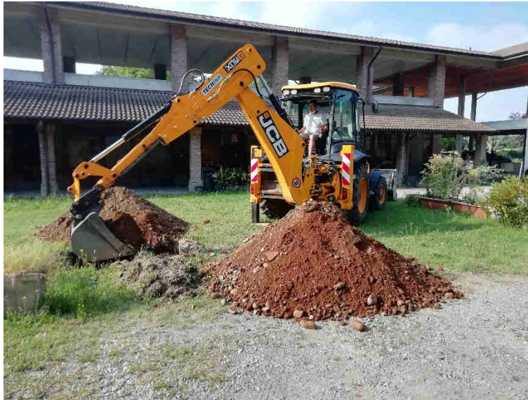
Foto 1: Ubicazione Trincea S1
