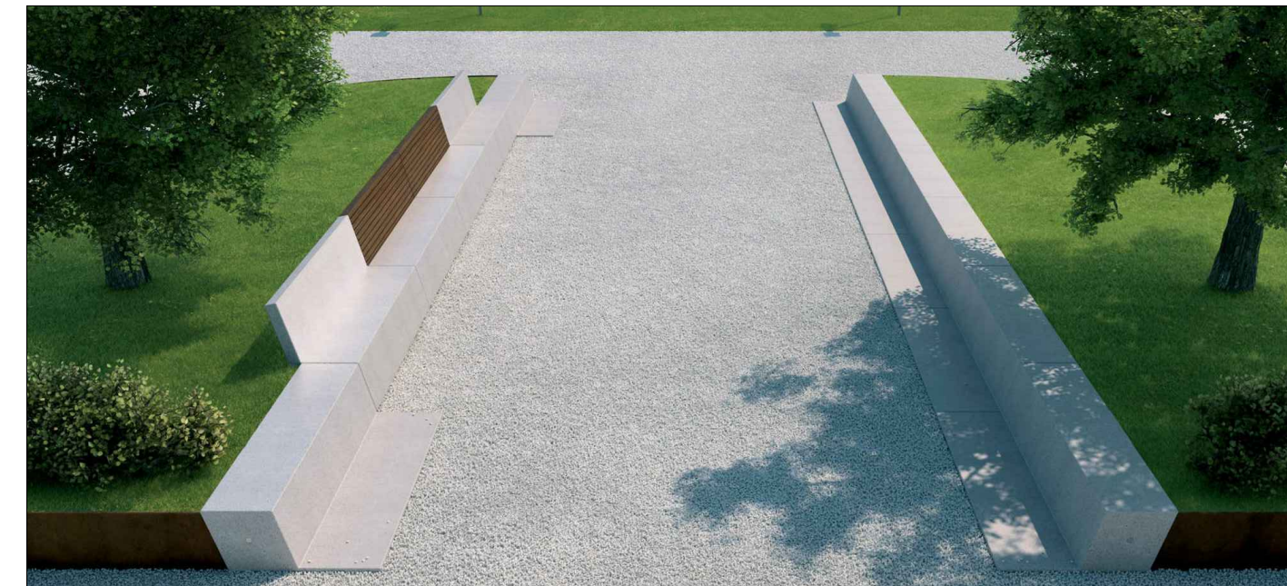
Aiuola rialzata; contenimento della terra realizzato con sedute monoblocco e cordolo in acciaio corten
