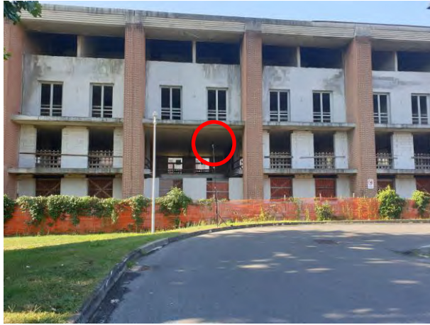
Punto 7 → via Roggia Arzona
