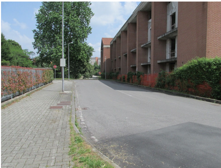
Foto 3 – vista da via Roggia Arzona (settore nord-ovest)
