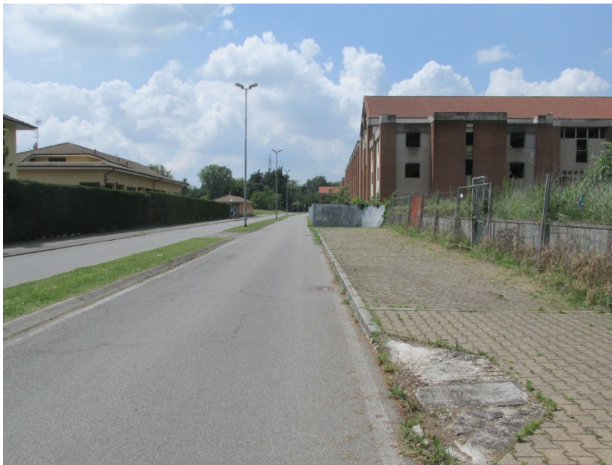
Foto 1 – vista da via Molinetto all'intersezione con via Roggia Renata (settore sud.est)
