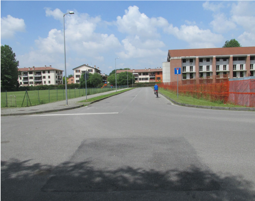
Foto 2 – vista da via Molinetto all'intersezione con via Roggia Arzona (settore sud-ovest)
