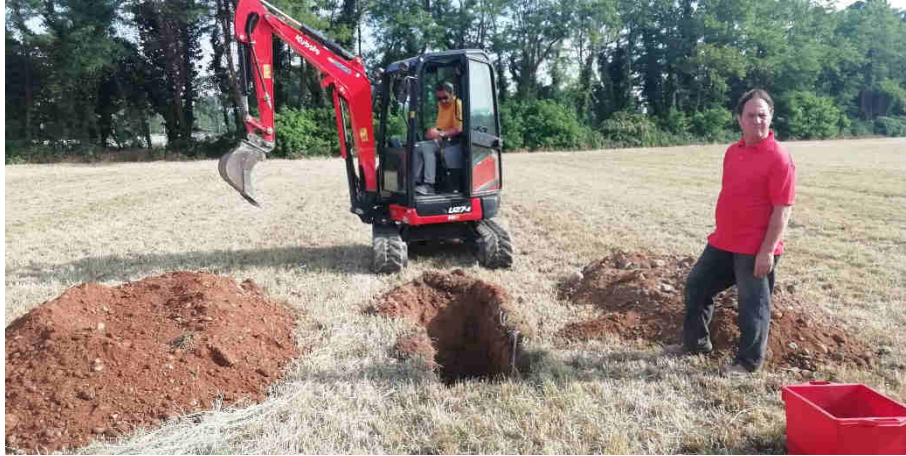
Foto 1: Esecuzione Trincea T1
