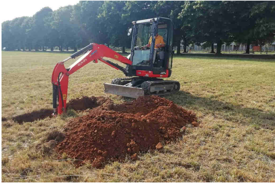
Foto 3: Esecuzione Trincea T2
