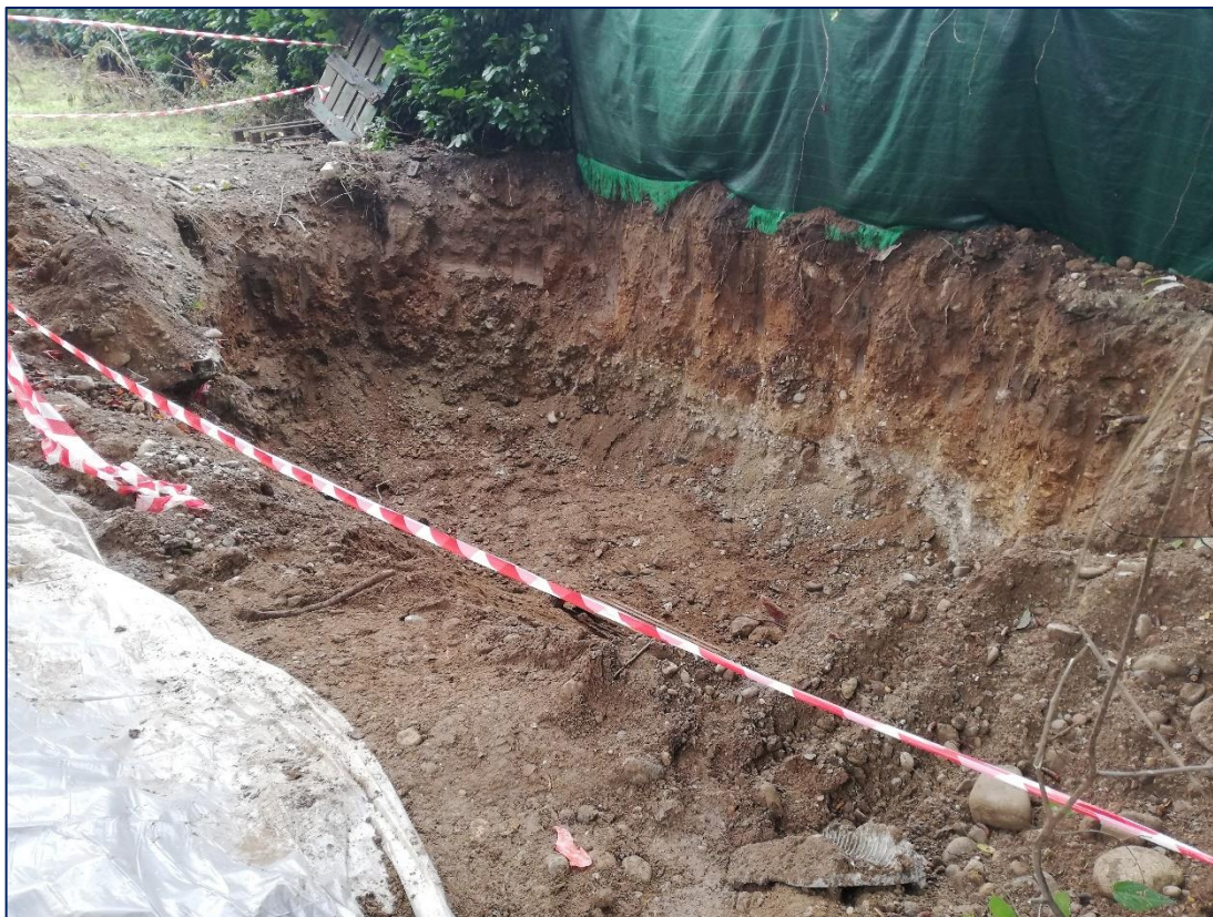
Figura 3 – Scavo di risulta
