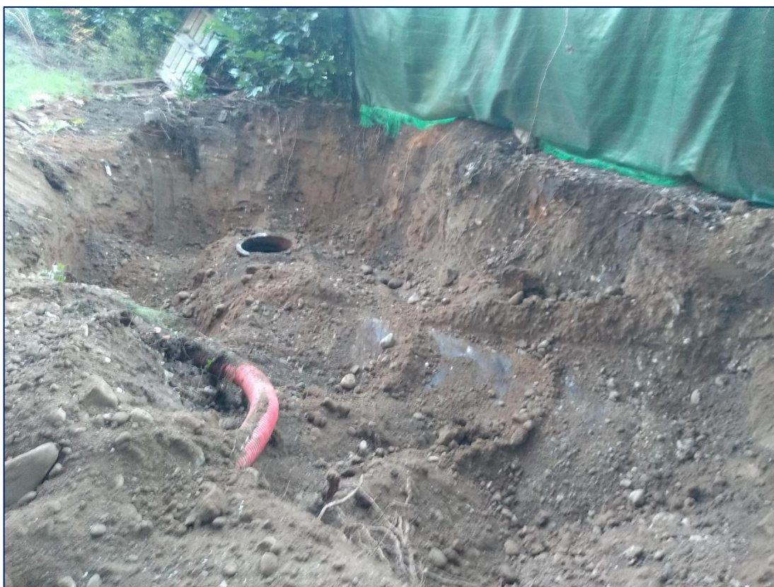
Figura 1 – Serbatoio interrato durante le operazioni di rimozione
