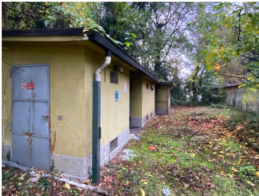
Figura 7 – Locali tecnici e alloggio generatore ex ospedale psichiatrico
