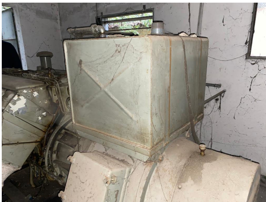
Figura 8 – Generatore ex ospedale psichiatrico e vasca alimentazione sommitale
