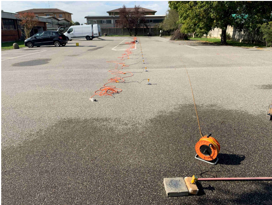
Foto 8: Prova Sismica MASW
