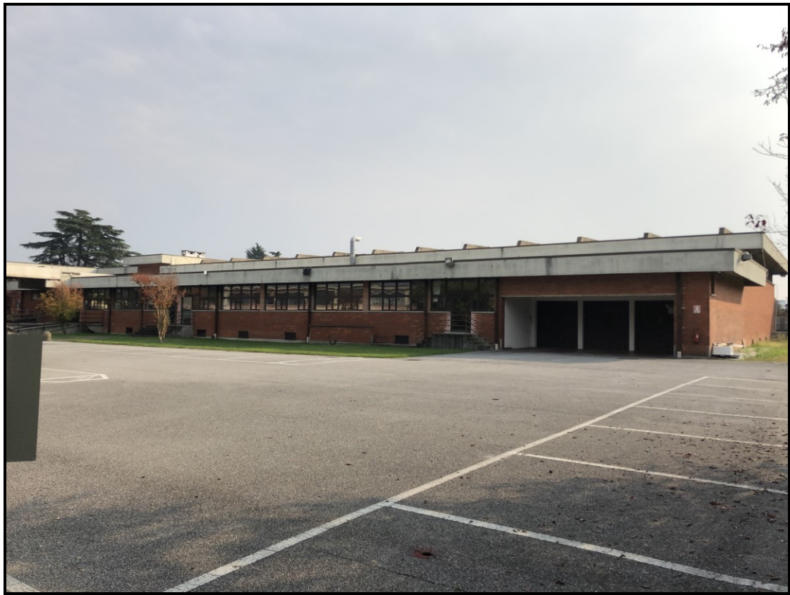
FOTO 3 – Vista posteriore complesso edilizio
