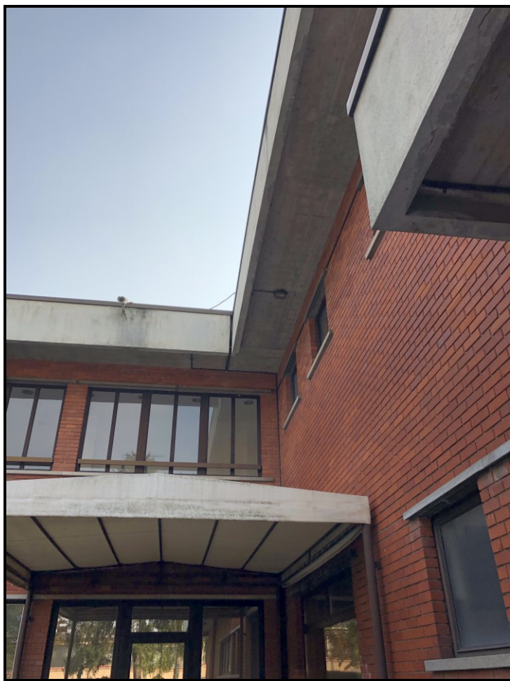
FOTO 11 – Particolare giunto strutturale (zona posteriore)
