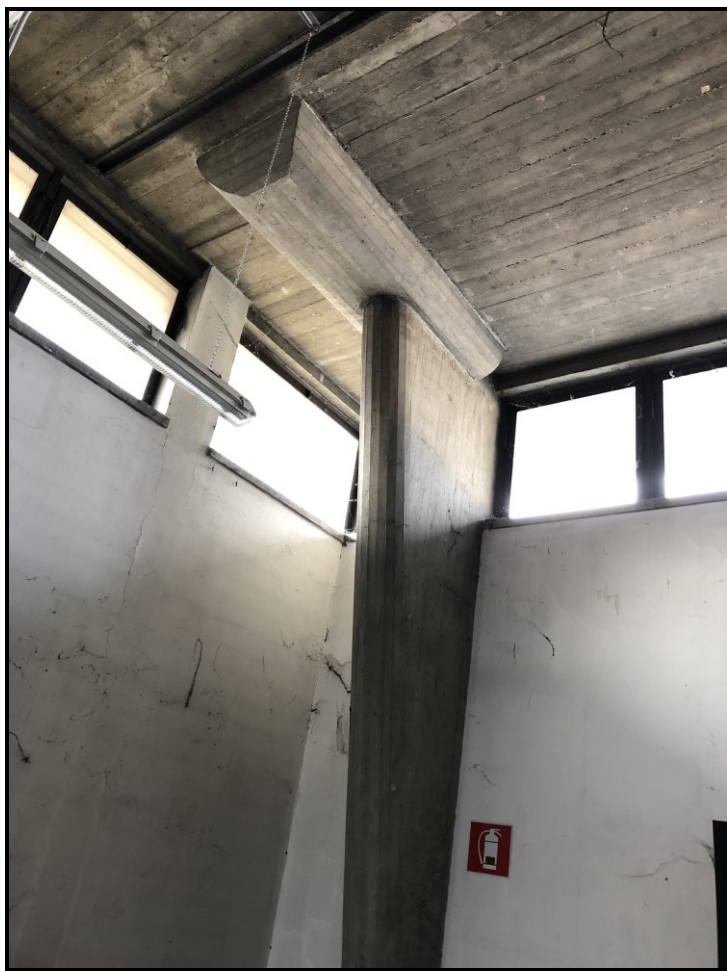
FOTO 17 – Particolare pilastro magazzino principale
