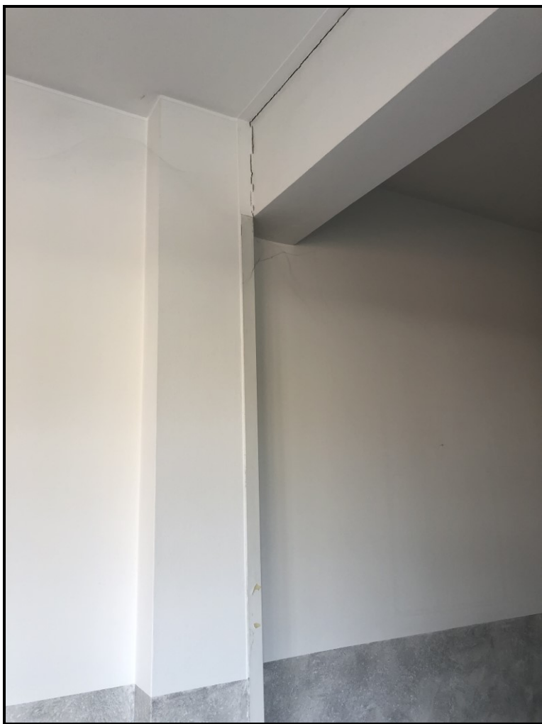
FOTO 24 – Particolare giunto strutturale piano primo
