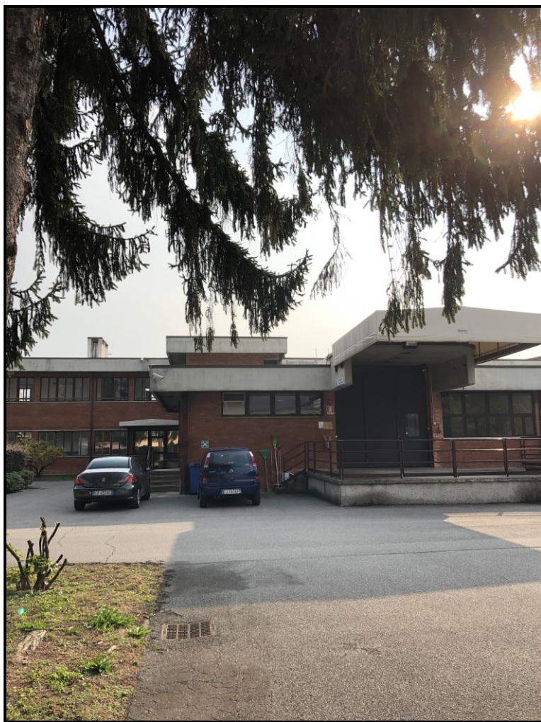
FOTO 4 – Particolare posteriore Unità “C”
