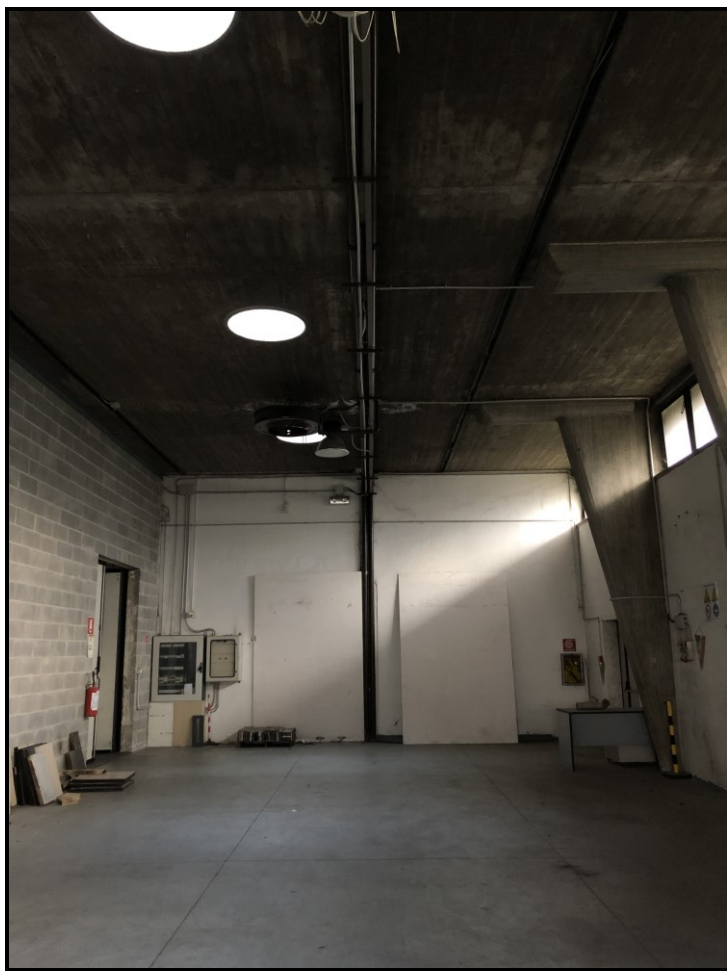
FOTO 14 – Particolare interno magazzino principale
