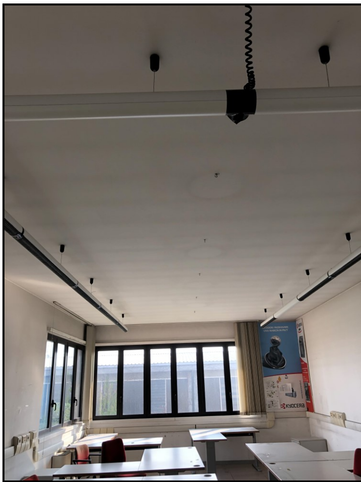
FOTO 25 – Particolare solaio piano primo Unità “B”
