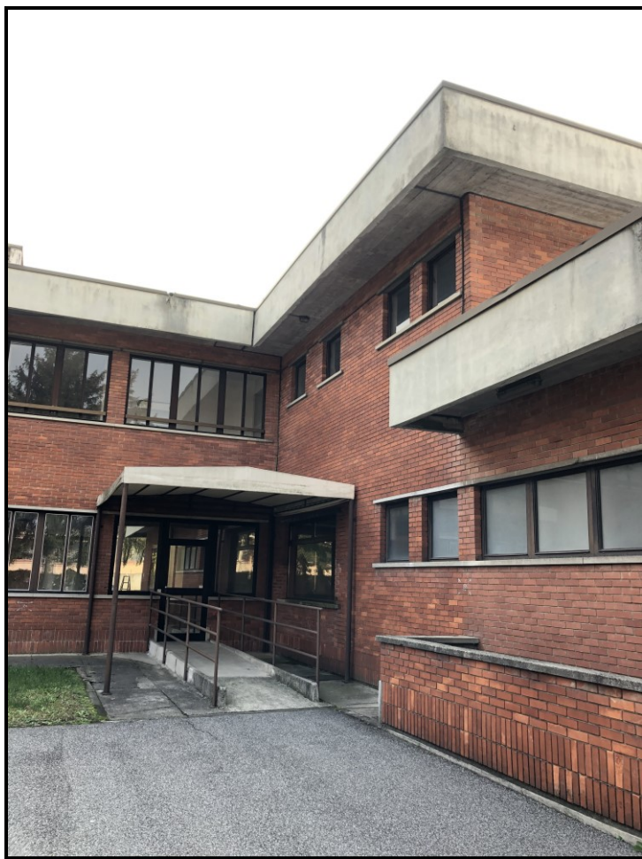
FOTO 8 – Vista posteriore zona giunto strutturale
