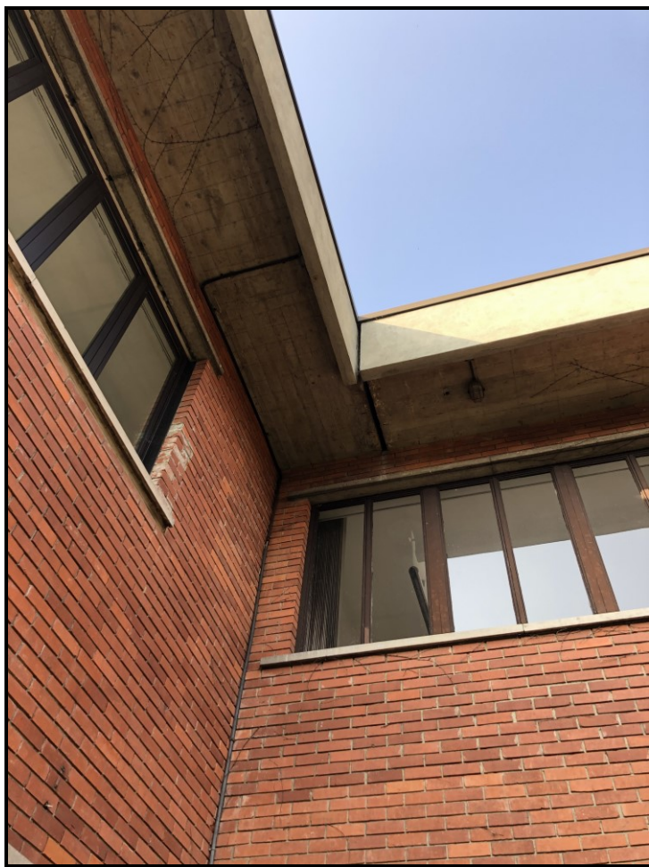
FOTO 10 – Particolare giunto strutturale (zona anteriore)
