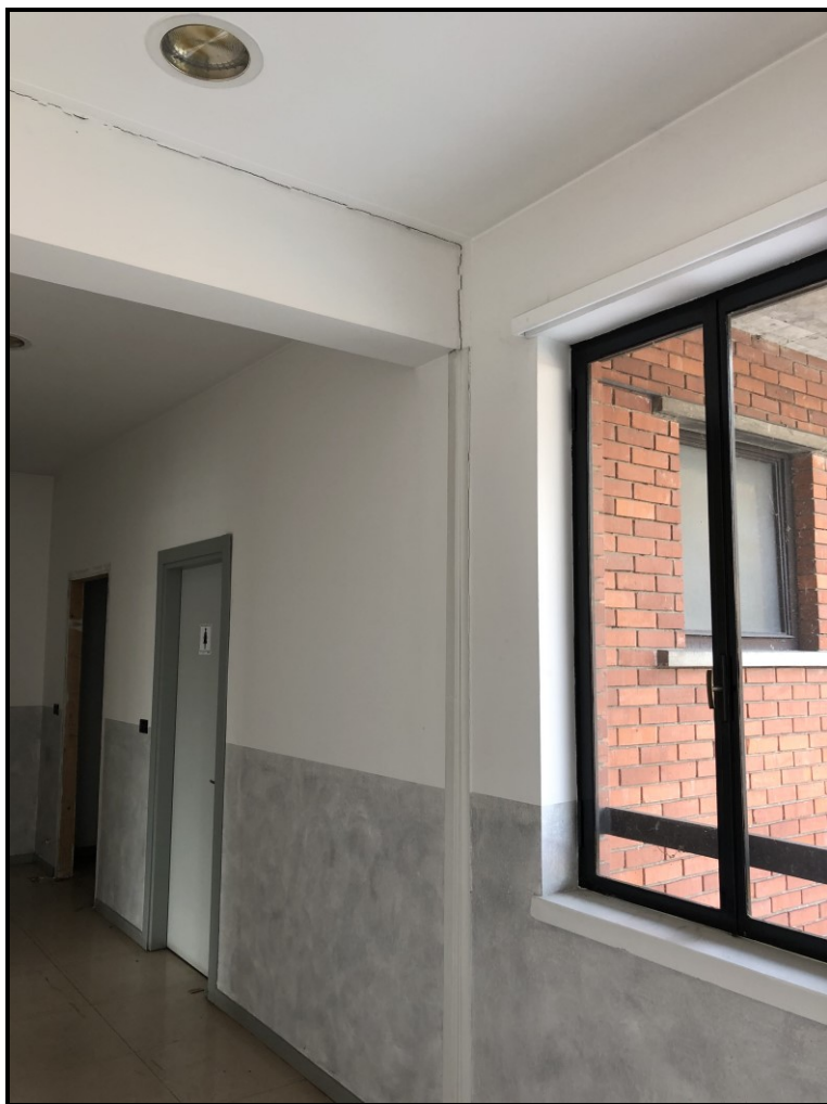
FOTO 22 – Particolare giunto strutturale piano primo
