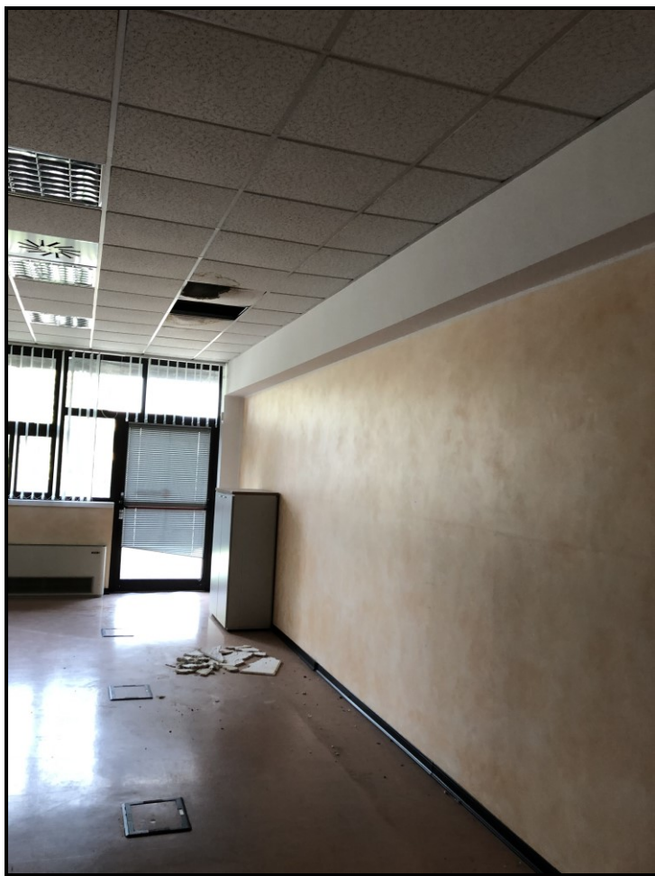
FOTO 19 – Particolare interni Unità “C”
