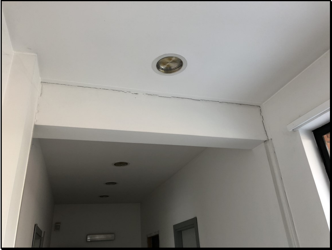
FOTO 23 – Particolare giunto strutturale piano primo
