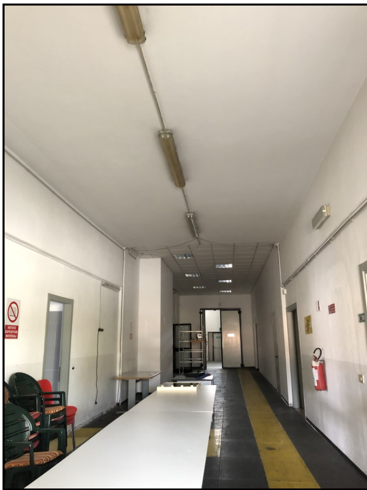
FOTO 18 – Particolare interni Unità “C”
