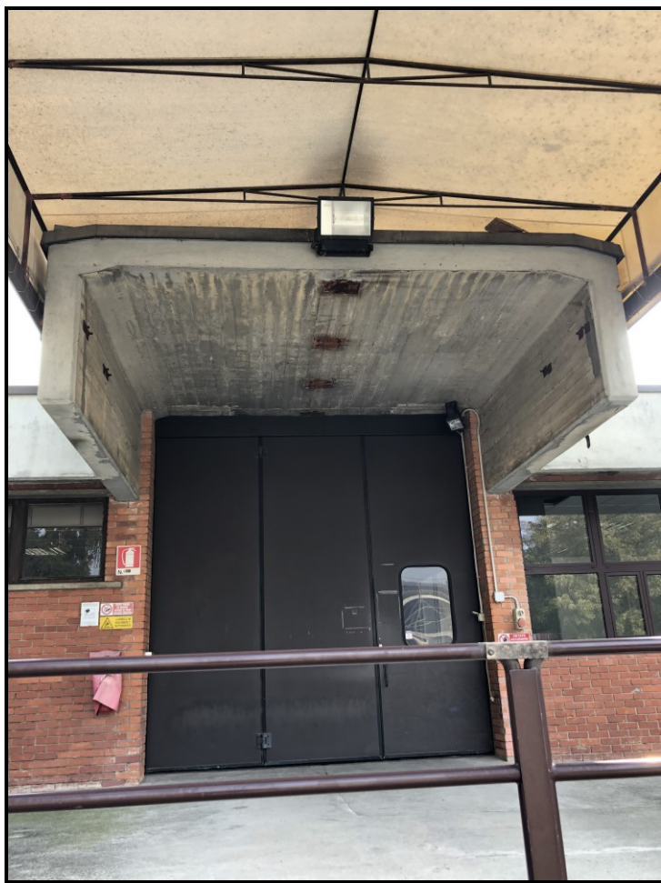
FOTO 6 – Particolare zona carico/scarico Unità “C”
