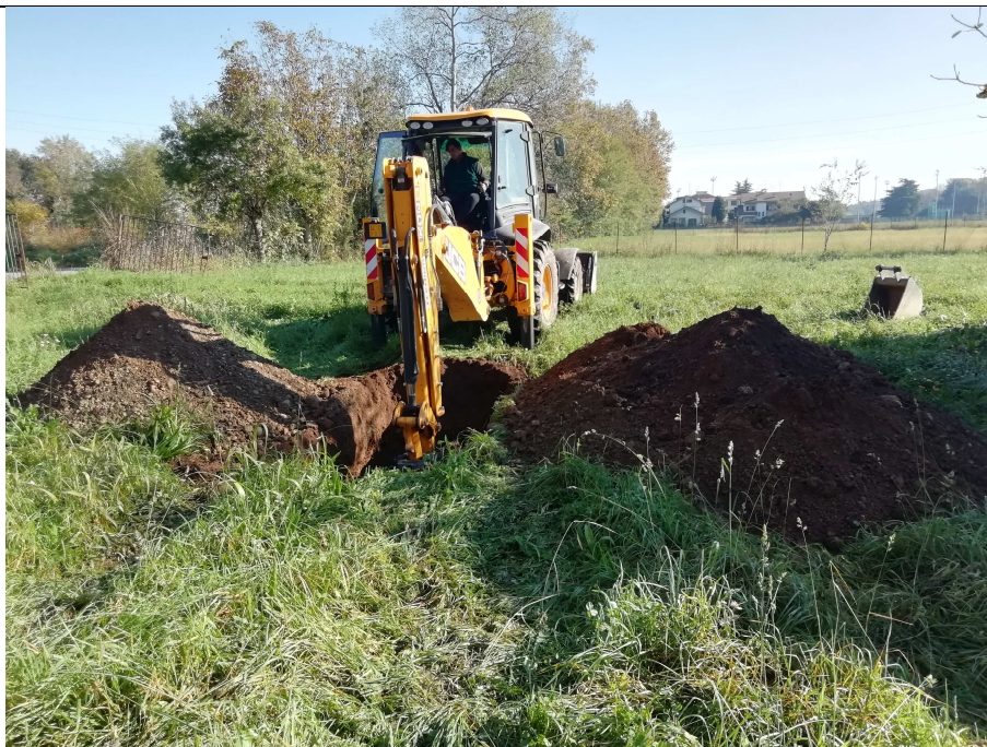
Area in cessione 2 – Esecuzione trincea T2
