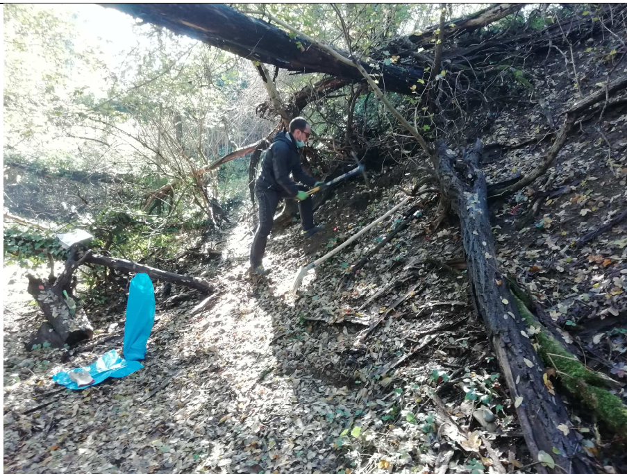
Area in cessione 3 F. 8 Mapp. 26 – Esecuzione scavo
