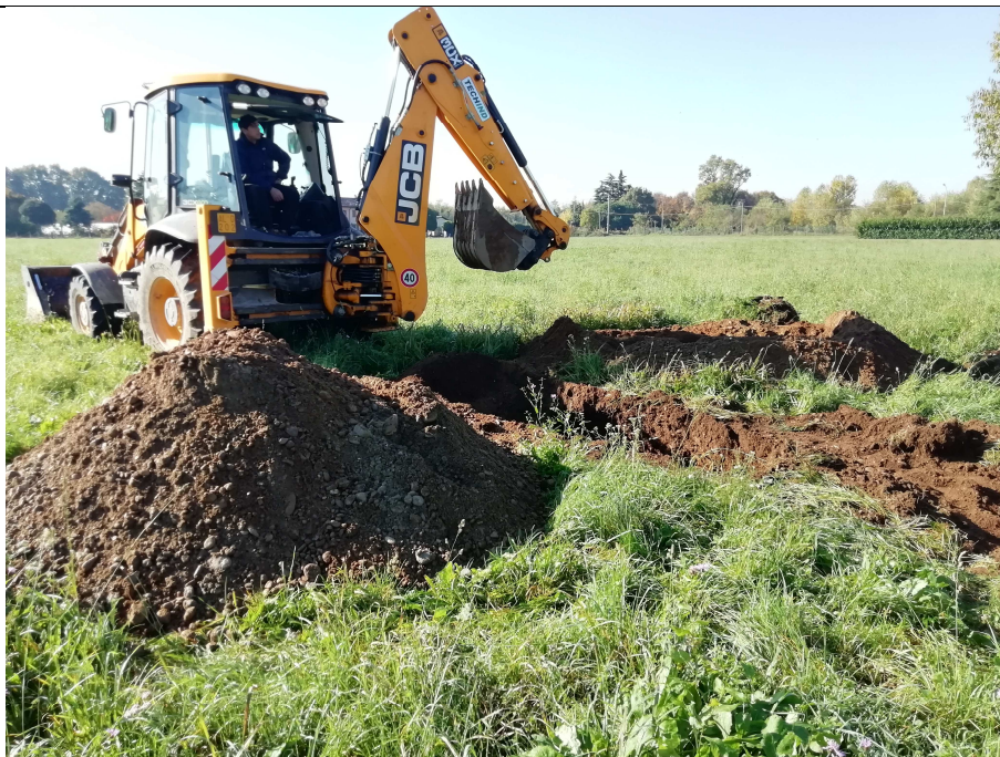
Area in cessione 2 – Esecuzione trincea T1
