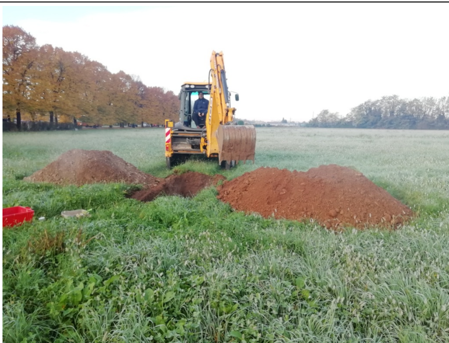
Area in cessione 1 – Esecuzione trincea T1
