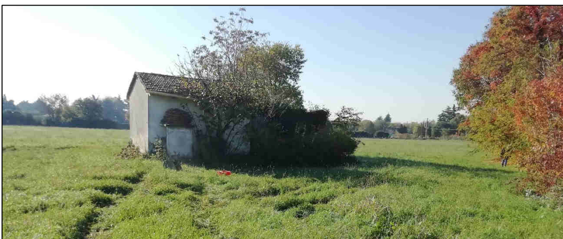
Figura 10: Fabbricato agricolo presente nell'Area 2
