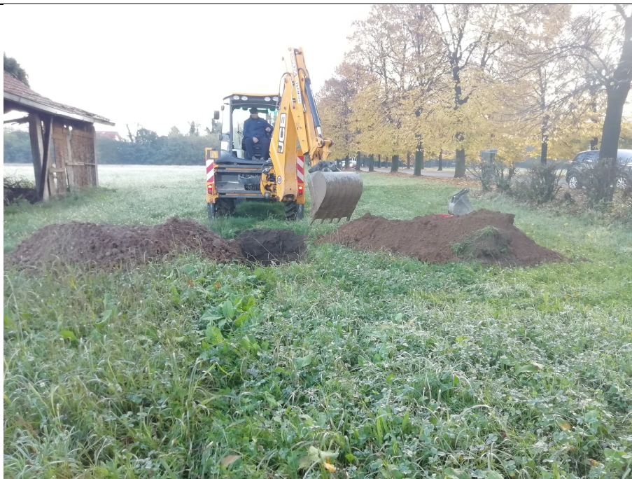
Area in cessione 1 – Esecuzione trincea T2
