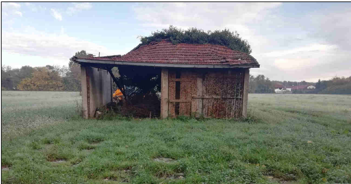
Figura 5: Fabbricato agricolo presente nell'Area 1
