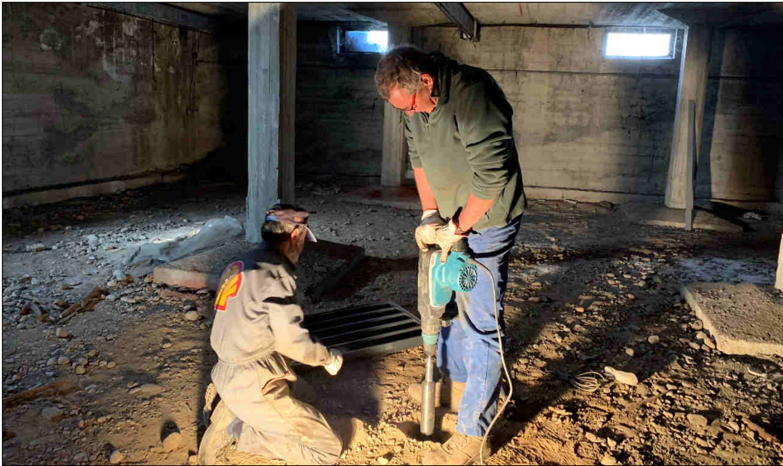
Figura 9: Settore operativo attività – Piano interrato non pavimentato
