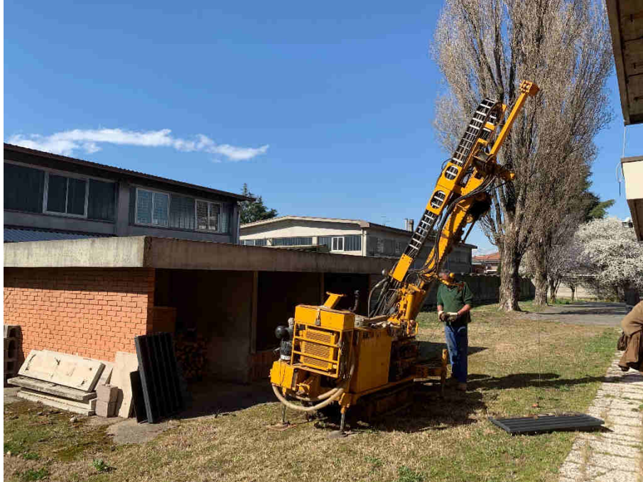
Sondaggio SD – inclinato a 60°
