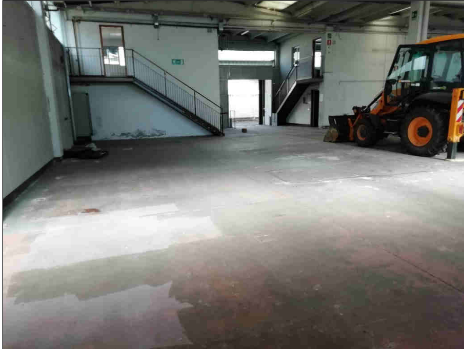
Figura 31: Capannone nord settore Est
