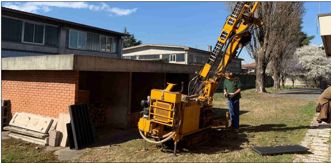
Figura 15: Settore Deposito - via Verdi 89/91 Cernusco s/N
