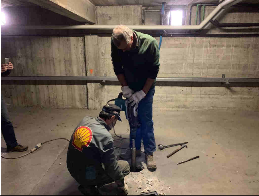
Sondaggio a carotaggio manuale SM3
