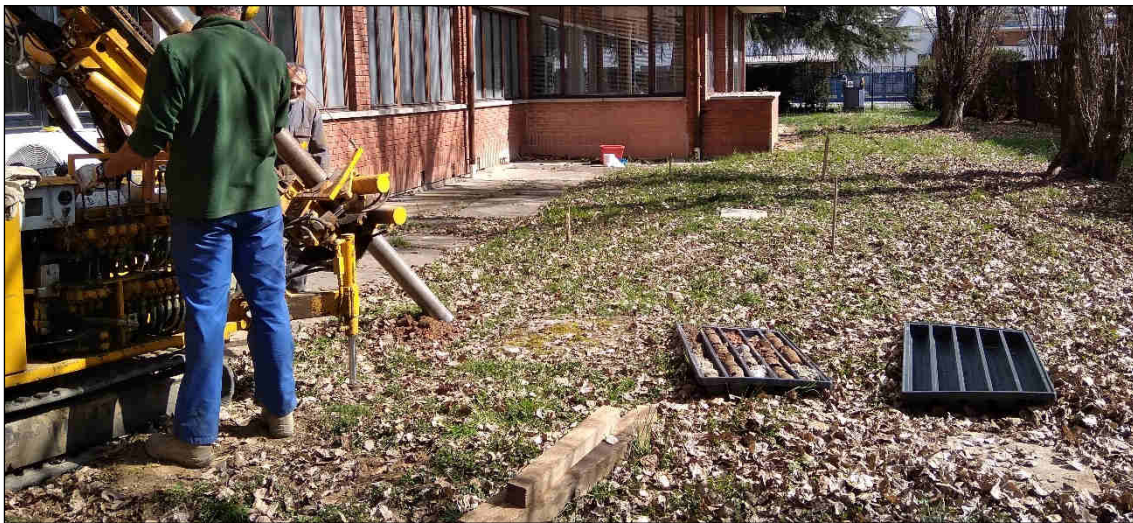
Figura 19: Settore aree verdi e corselli – Corsello sud (vista verso est) via Verdi 89/91 Cernusco s/N
