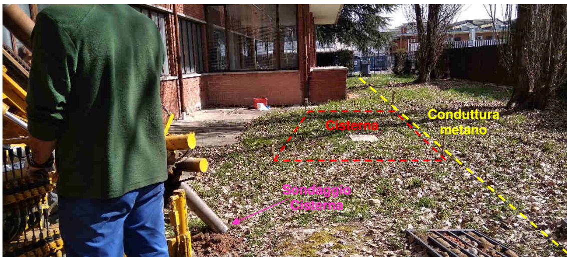
Figura 14: Settore Serbatoi Interrato – via Verdi 89/91 Cernusco s/N
