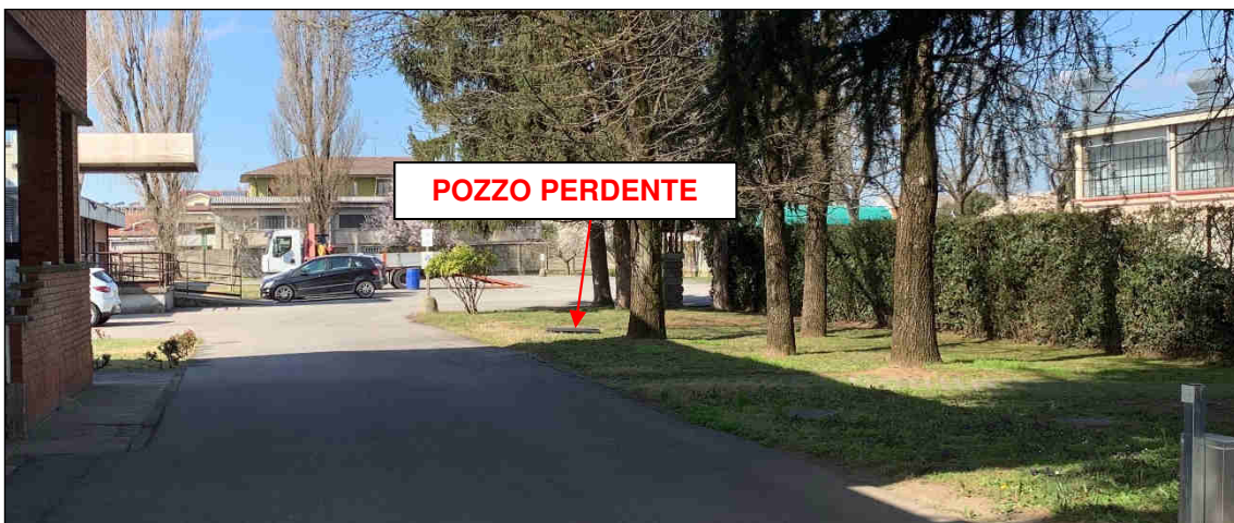
Figura 12: Settore Pozzo Perdente
