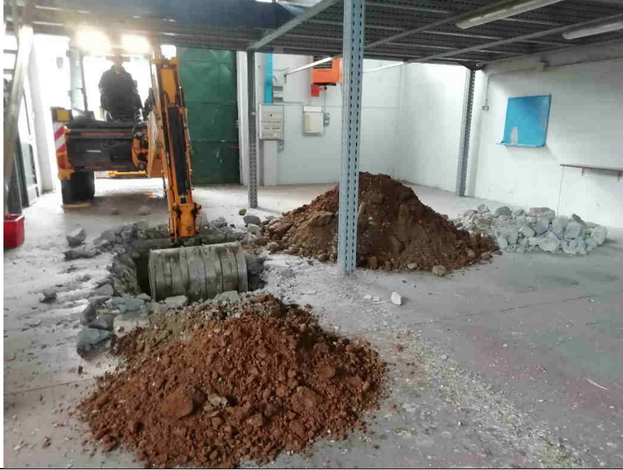
Esecuzione Trincea T1
