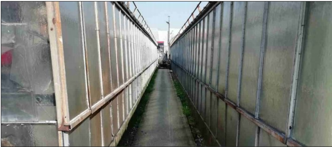
Figura 12: corsello divisorio tra le due serre
