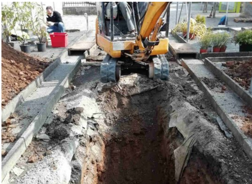
Foto 7: Esecuzione trincea T4
