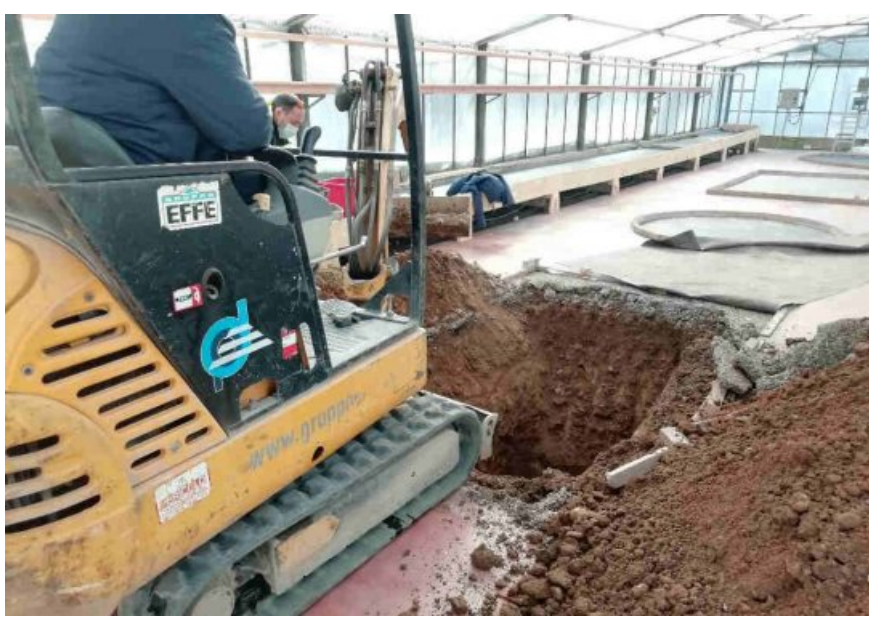
Foto 5: Esecuzione trincea T3
