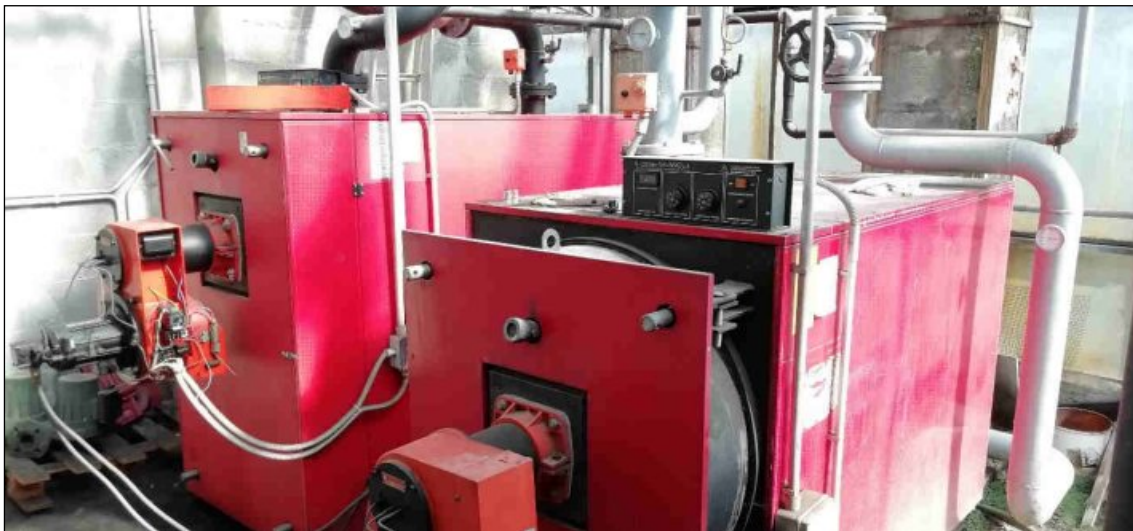
Figura 15: Bruciatore ubicato su pavimentazione in CLS nella serra Ovest
