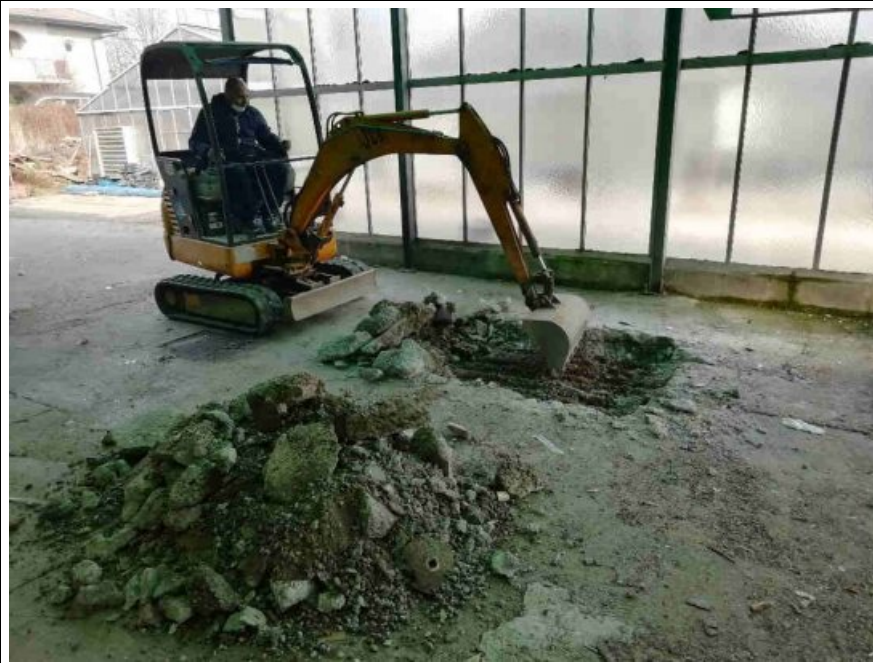
Foto 1: Esecuzione trincea T1
