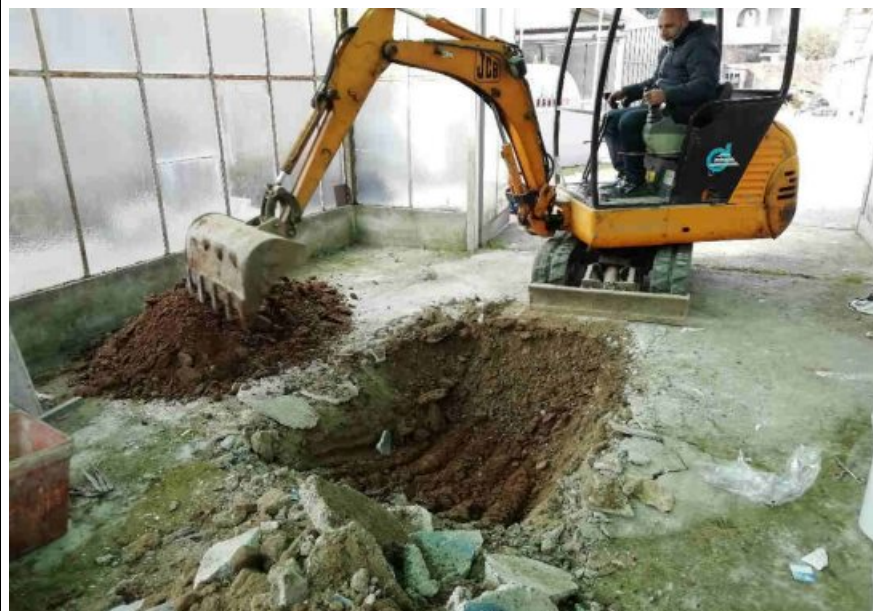
Foto 3: Esecuzione trincea T2
