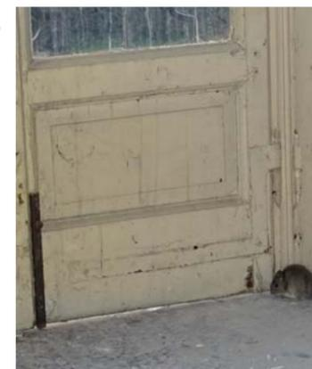
CERNIERE SU TELAIO FISSO, COLLEGATE AL TELAIO MOBILE CON ELEMENTI METALLICI AD "L"
