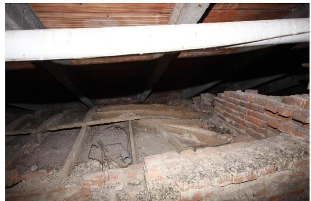
*Degrado della volta lignea sulla scala di servizio dell'ammezzato est, estradosso*
