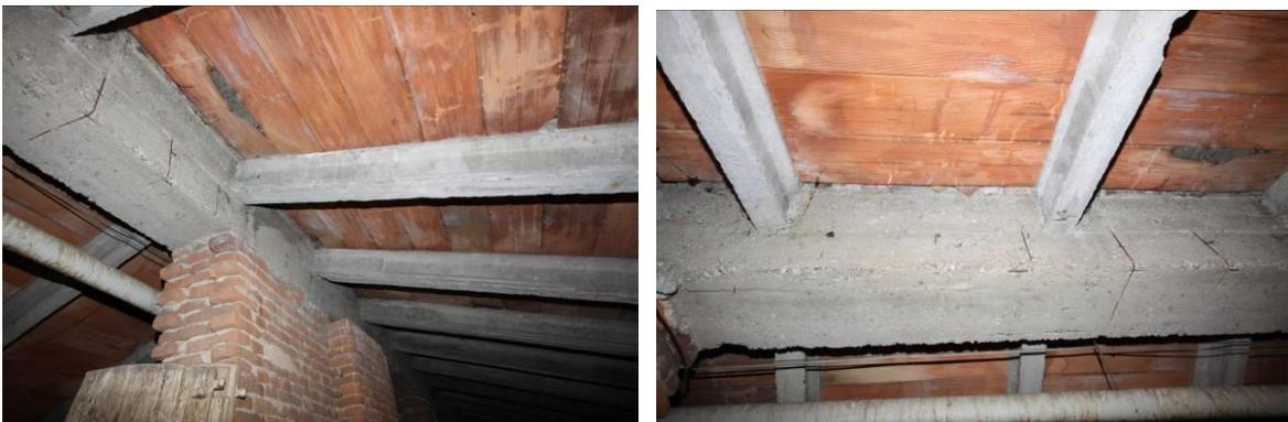
*La trave di colmo in C.A.: in vista l'armatura ossidata. Evidenti le tracce di umidità sui tavelloni.*
