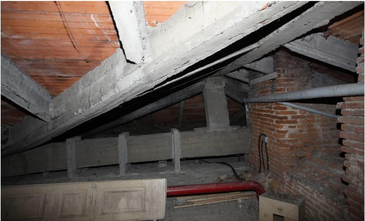
*Nodo di connessione colmo-displuvi: il sostegno del nodo è realizzato con falsa "capriata" realizzata in calcestruzzo armato. Il pilastro che sostiene il nodo poggia in falso sulla trave e risulta fortemente fuori piombo. È visibile inoltre la presenza di "appensioni" sempre in cls armato a collegare la trave in spessore di solaio con la trave della falsa capriata.*
