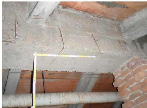
I travetti a sostegno del tavellonato sono costituiti da elementi in cls prefabbricato con sezione ad I; questi elementi risultano essere di qualità migliore rispetto alle parti realizzate in opera, ma si rileva comunque la presenza di distacco di copriferri con esposizione ed ossidazione delle armature.
