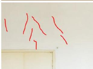
Sono tracciati con linea di colore rosso i fenomeni fessurativi verosimilmente riconducibili a fenomeni di cavillatura degli intonaci, fessurazioni a reticolo, ed in generale ove la fessurazione paia interessare solo lo spessore dell'intonaco.
