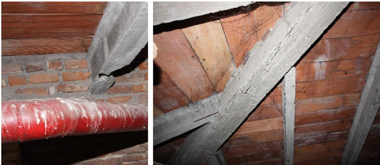
Sono state rilevate puntuali situazioni di criticità, per la presenza di porzioni di struttura realizzati con tecniche ed elementi non “convenzionali”; in primis le capriate formate con travetti prefabbricati e catene in filo di ferro e la “falsa capriata” con il pilastro in falso e pesantemente fuori piombo. Di dubbia efficacia pare inoltre l'appensione con elementi in c.a. realizzata sulla trave della falsa capriata stessa.
