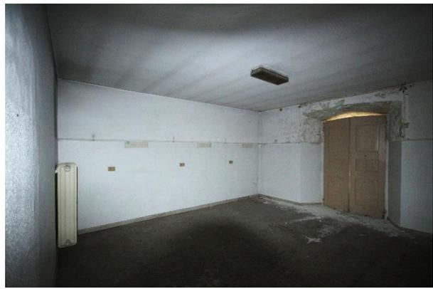
*Il solaio a copertura dell'ammezzato ovest realizzato in latero-cemento, estradosso visto dal sottotetto ed intradosso visto dal locale al secondo ammezzato; evidente l'orditura grazie alle tracce di termoforesi dei travetti.*
