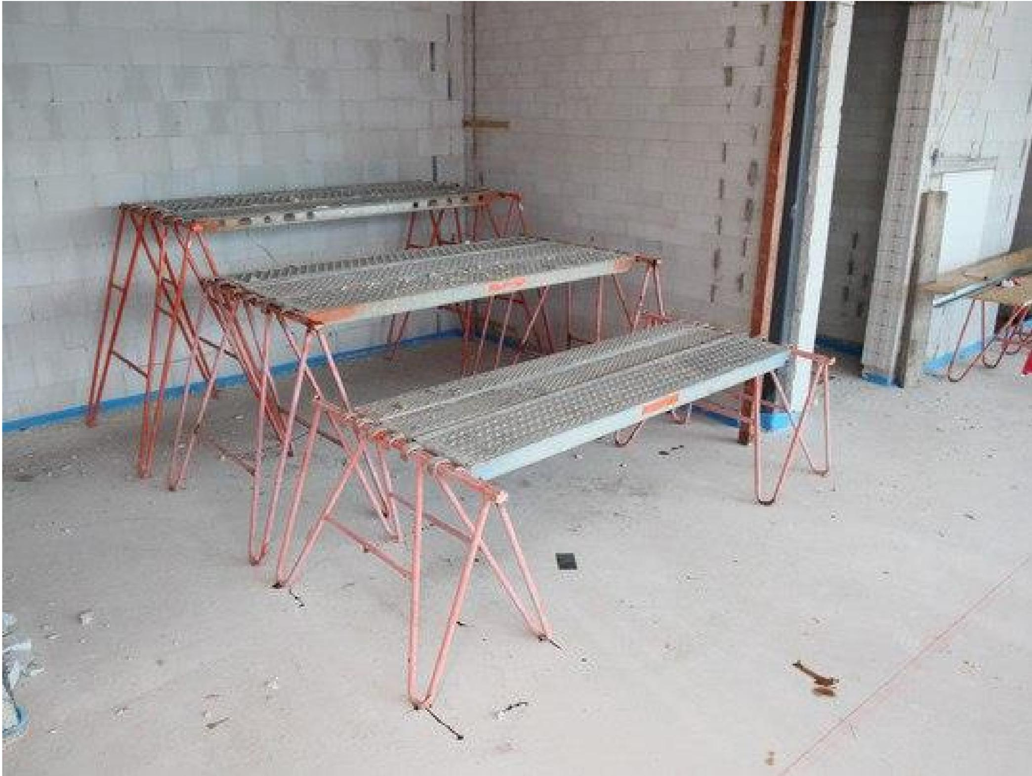
Piani su cavalletti da usare eventualmente nei piani ammezzati, previo ancoraggio al dispositivo di sicurezza di tipo 'a corpo morto' (Sicurpal), con cordino regolato della distanza minima necessaria per raggiungere il serramento.
