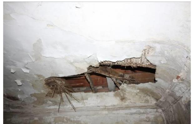
*Degrado della volta lignea sulla scala di servizio dell'ammezzato est, intradosso*
