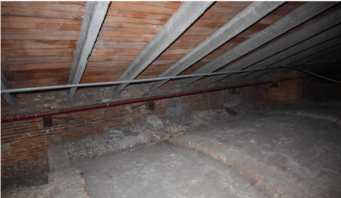
*Tavellonato sui nuovi travetti prefabbricati in C.A. Immorsati nella muratura sottostante sono visibili monconi di elementi lignei verosimilmente rimanenze della precedente copertura. Evidenti le tracce di umidità sui tavelloni.*
