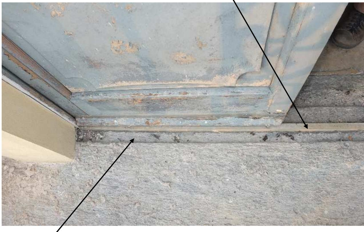
Stuccatura riempitiva da eseguire con una miscela di calce idraulica, polvere di marmo e resina acrilica, stesa con pendenza verso l'esterno.
