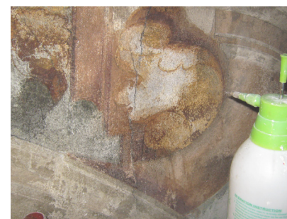
PULITURA AD UMIDO CON SPRAY ACQUA
