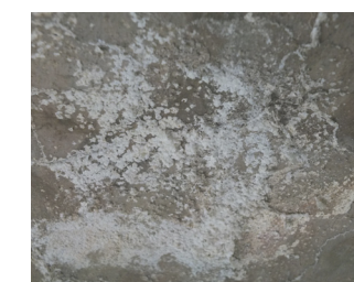
Concrezione salina
