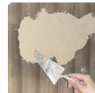
RICOSTRUZIONE LACUNE DI INTONACO
