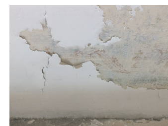
Esfoliazione della tinta e rinvenimento della decorazione sotto lo scialbo
