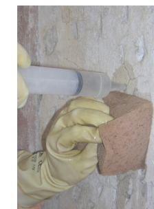
CONSOLIDAMENTO IN PROFONDITA'
