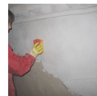
RIPRISTINO INTONACHINO TIRATO A SPUGNA
