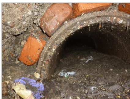
Figura 20 - Materiale accumulato nel pozzetto al nodo 398
