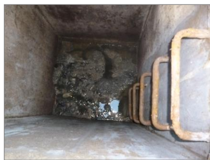
Figura 21 - Materiale accumulato nel pozzetto al nodo 395
