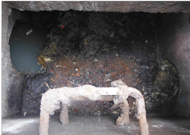
Figura 29 – Materiale depositato all'interno del pozzetto relativo al nodo 2420
