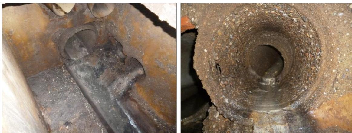
Figura 11 – Pozzetto in corrispondenza del nodo 321 all'angolo tra le vie Gorizia e Briantea
