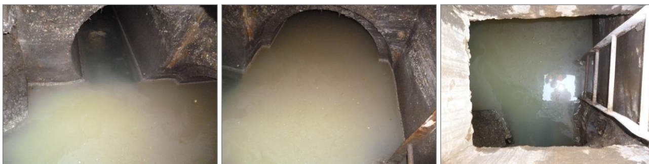
Figura 10 – Partitore in corrispondenza del nodo 322 all'angolo tra le vie Gorizia e Briantea
