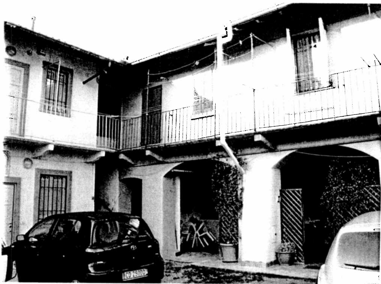
Particolare fabbricato dal cortile interno
