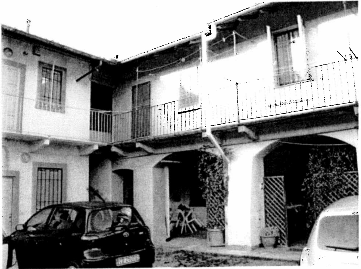
Particolare fabbricato dal cortile interno
