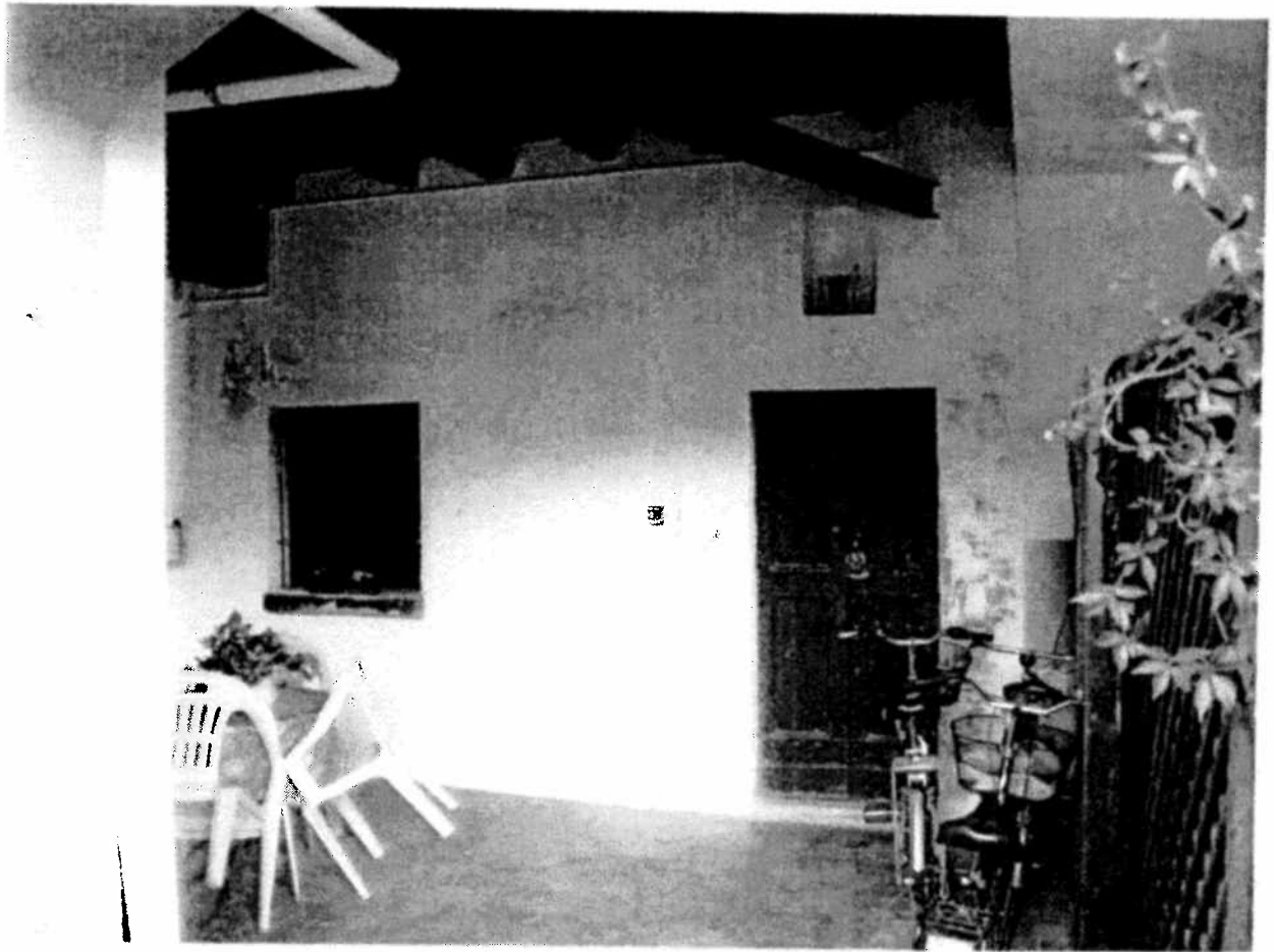
Particolare ingresso interno
