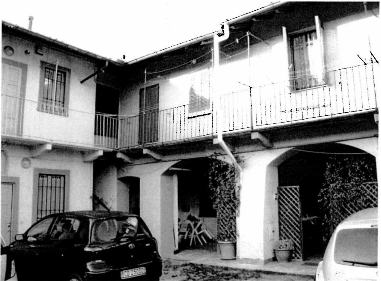
Particolare fabbricato dal cortile interno
