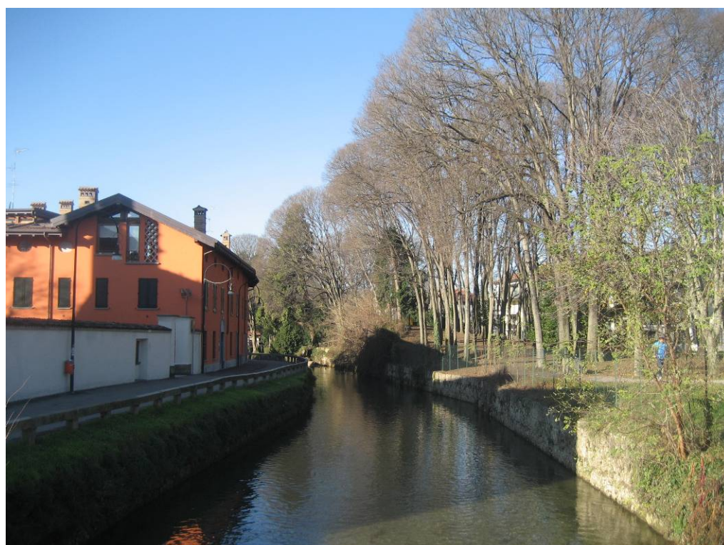
Foto 2. Vista del Naviglio Martesana in prossimità della Via Cavour.
