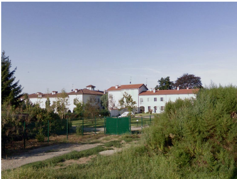
Foto 1. Vista del complesso della Villa dalla S.P. 121.
