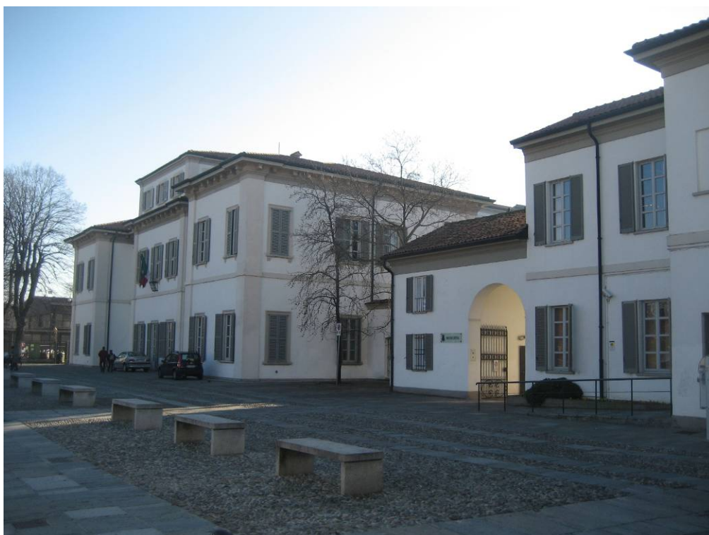
Foto 2. Vista della Villa Greppi dalla Piazza unità d'Italia.
