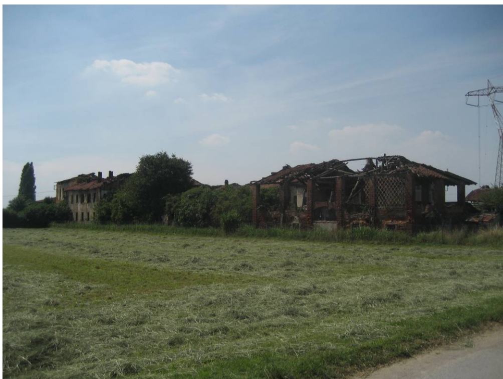
Foto 2. Vista del complesso cascinale dalla Via Adua (sud-est).
