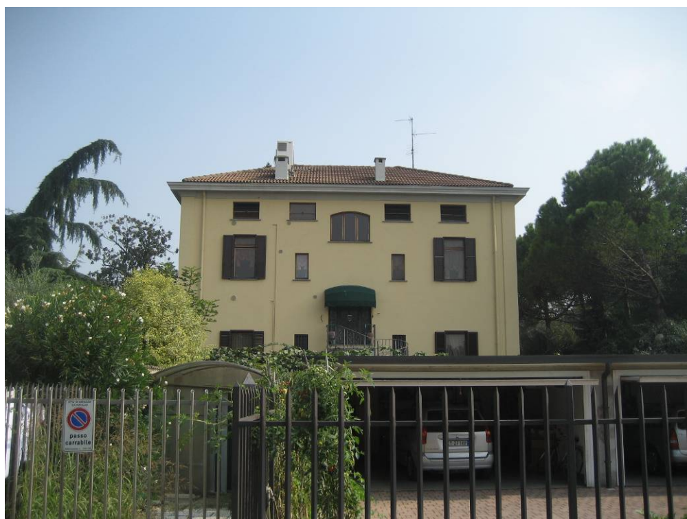
Foto 2. Vista del prospetto ovest della Villa dal quale risultano evidenti segni di manomissioni sulla facciata.
