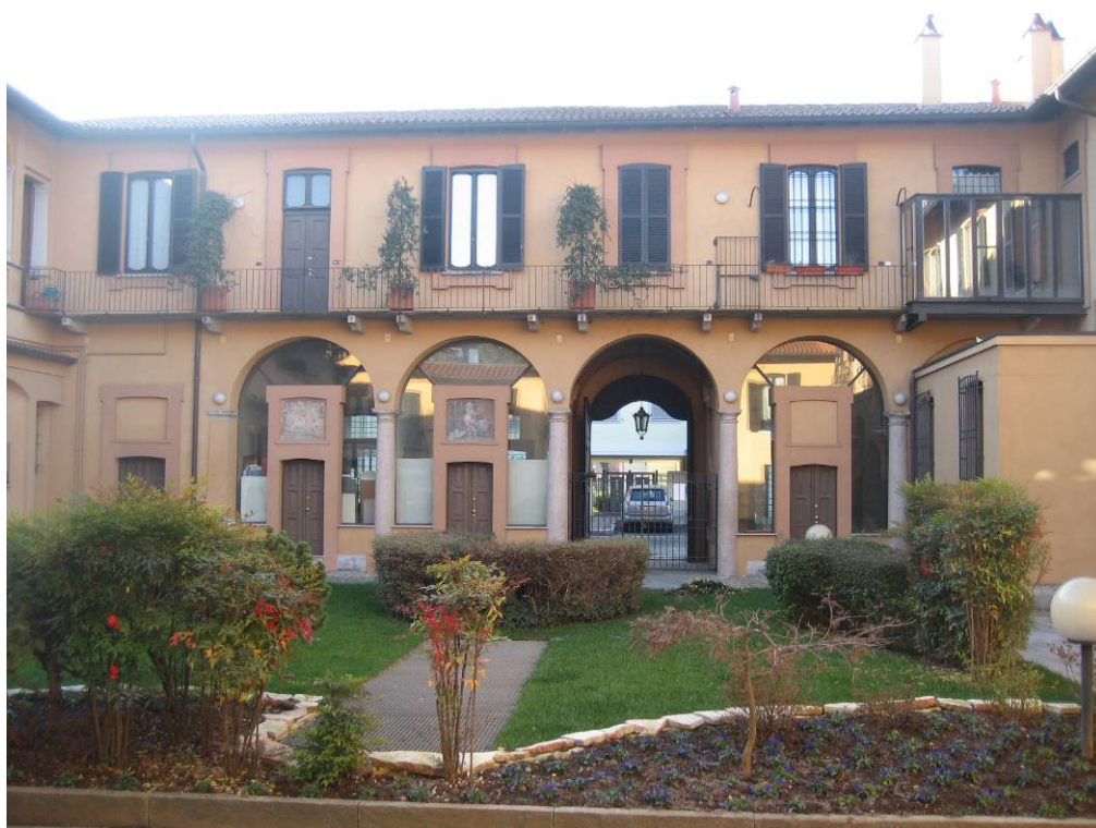
Foto 2. Vista della corte interna del Palazzo Viganò.
