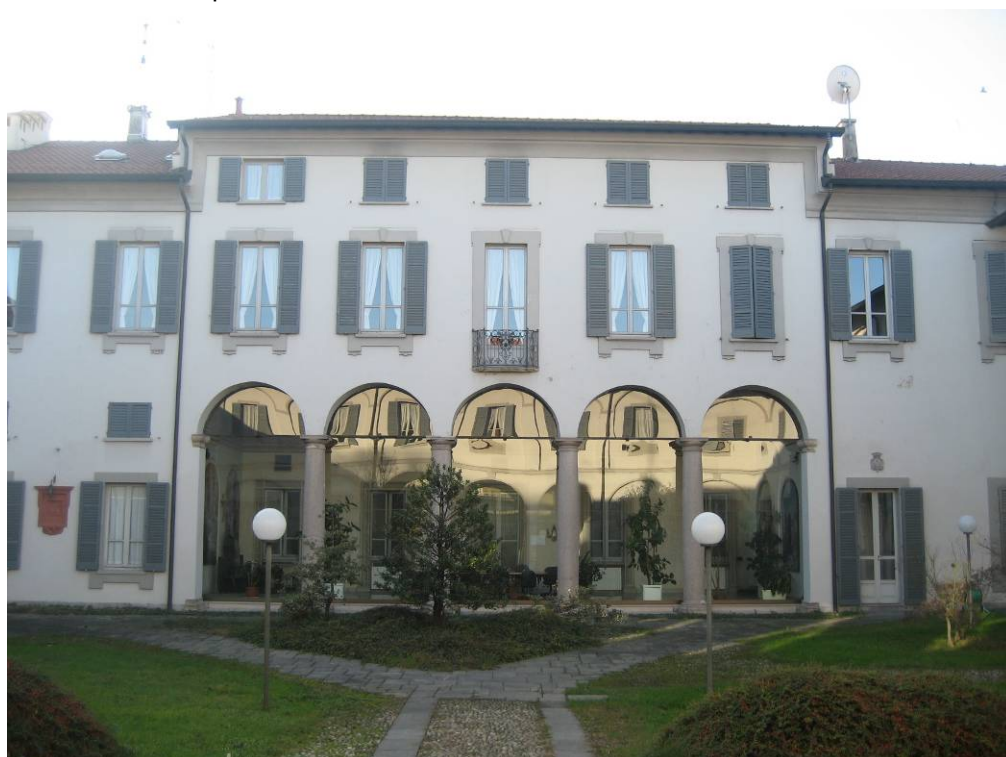
Foto 2. Vista dalla corte interna del portico settentrionale.
