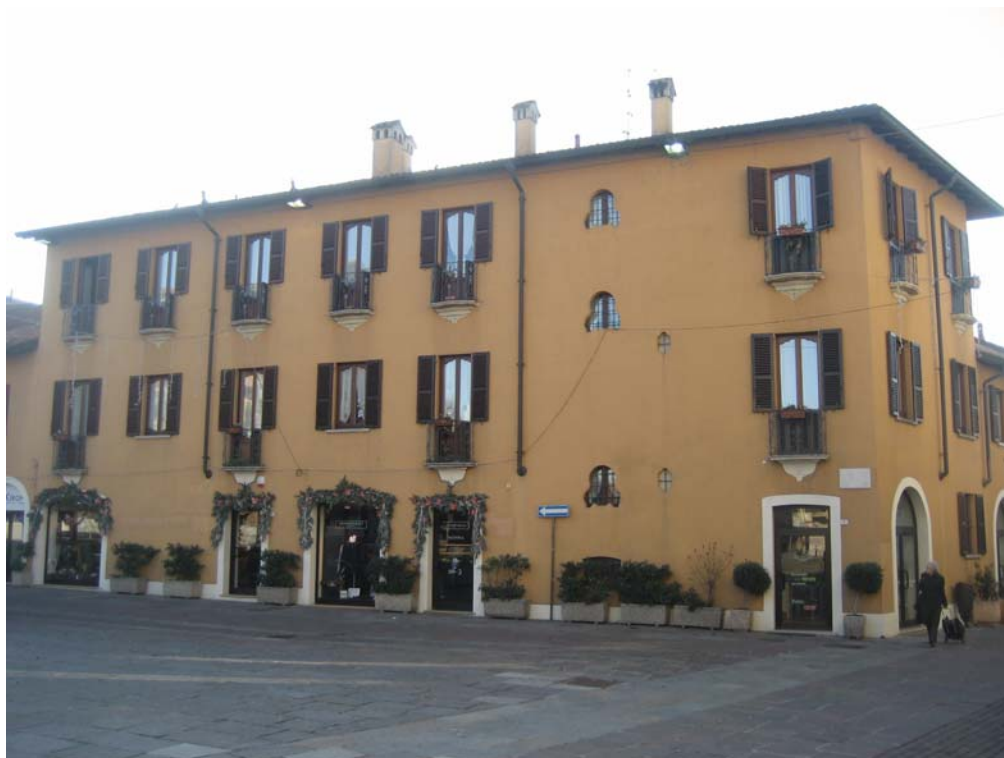
Foto 1. Vista complessiva dell'edificio da Piazza Conciliazione/Via delle Marcelline.
