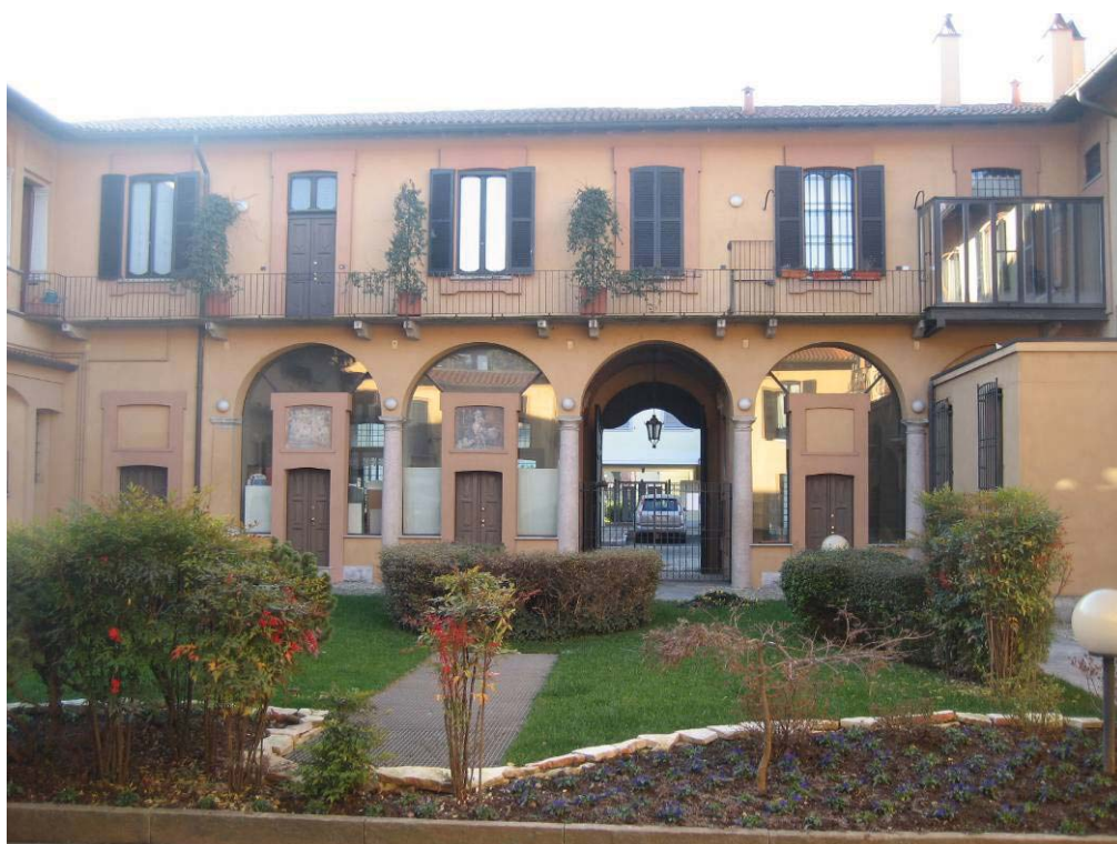
Foto 2. Vista della corte interna del Palazzo Viganò.
