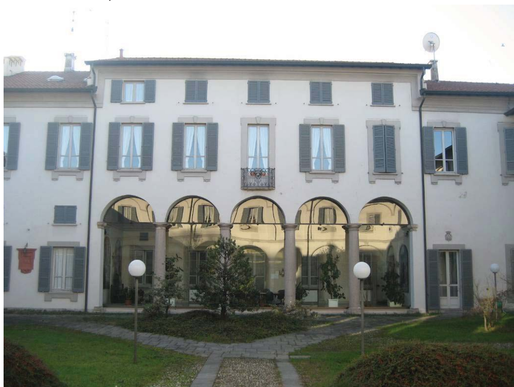
Foto 2. Vista dalla corte interna del portico settentrionale.
