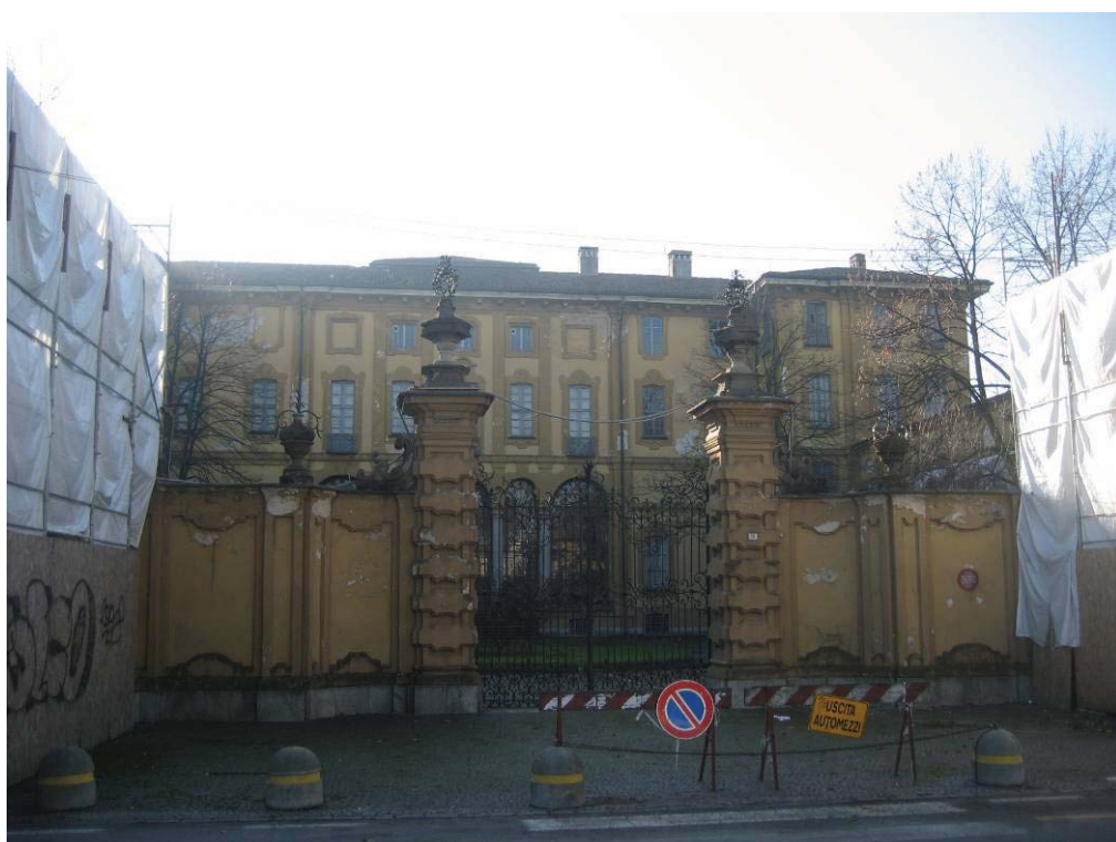
Foto 2. Vista dell'ingresso monumentale dalla via Cavour.
