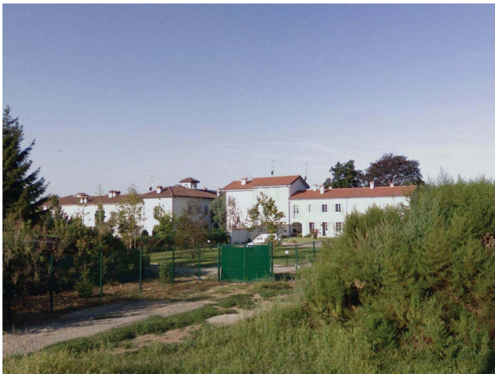
Foto 1. Vista del complesso della Villa dalla S.P. 121.
