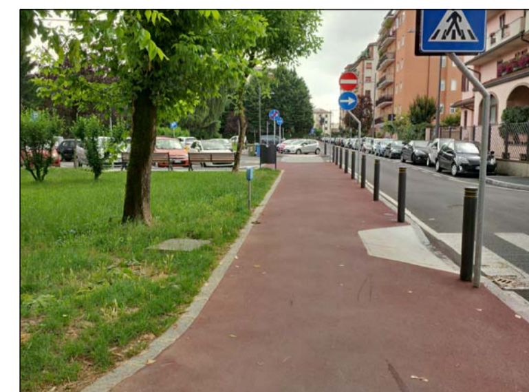
La sezione stradale della via di connessione prevede stadi auto in autobloccante, pista ciclopedonale in asfalto rosso colato e nastro stradale in asfalto inseriti in ambito verde (aiuole e giardini)
