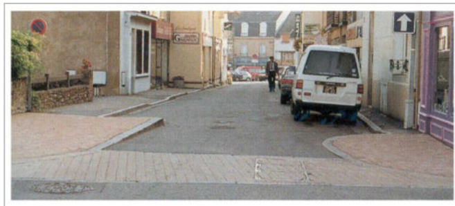
Figura 7.1.24– Impiego di “orecchie” ad un incrocio
