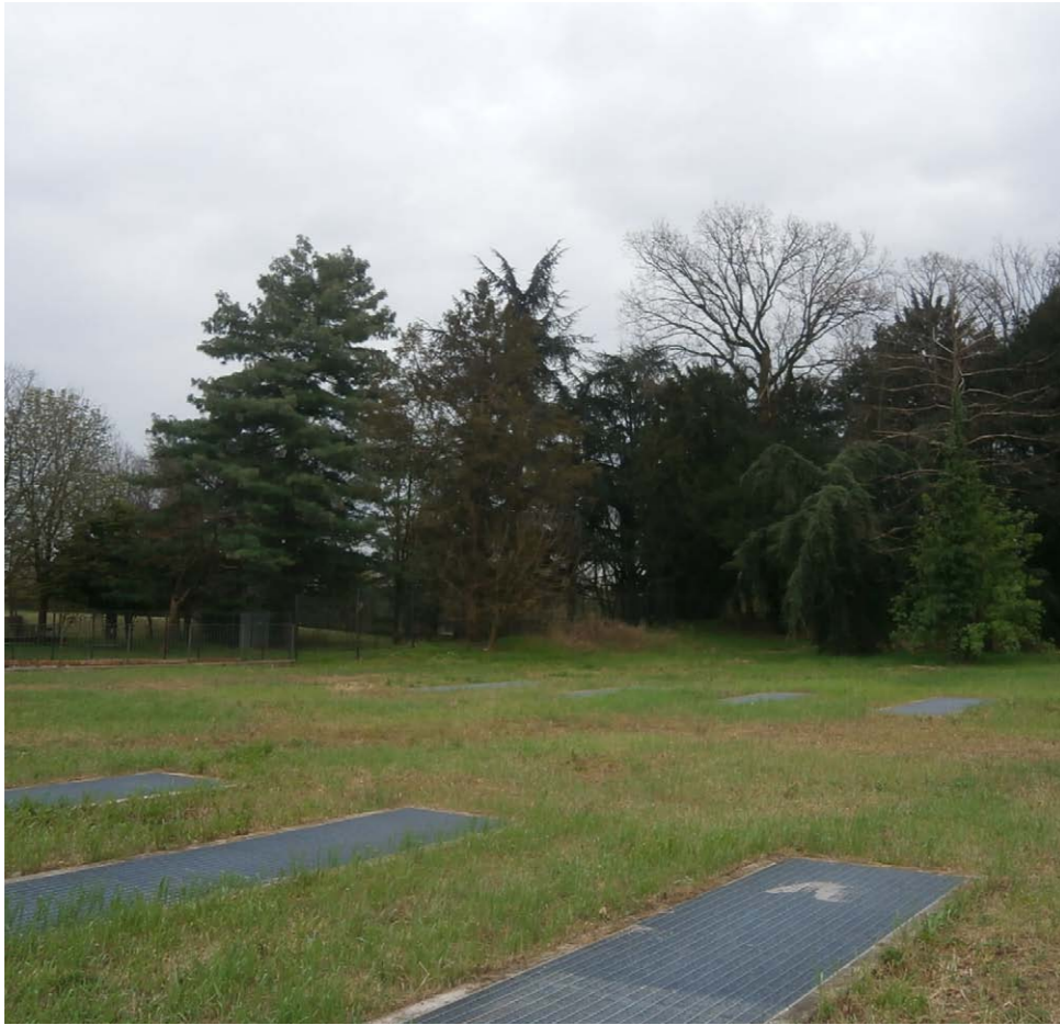
1_ Griglie di aerazione del parcheggio interrato.
