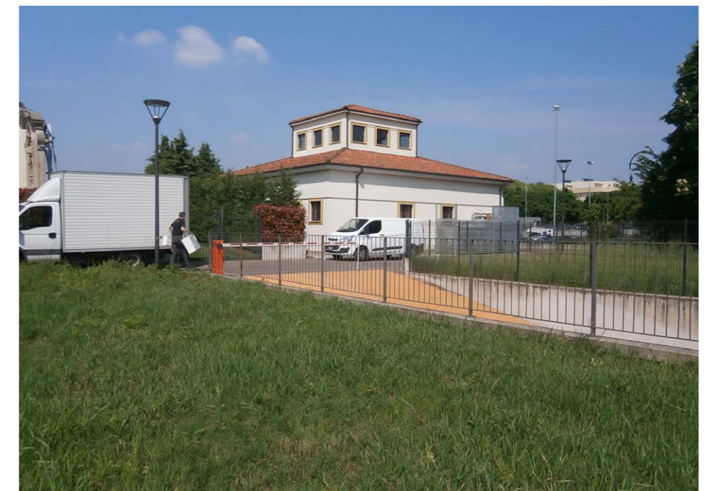
4_ Rampa che conduce al parcheggio interrato.
