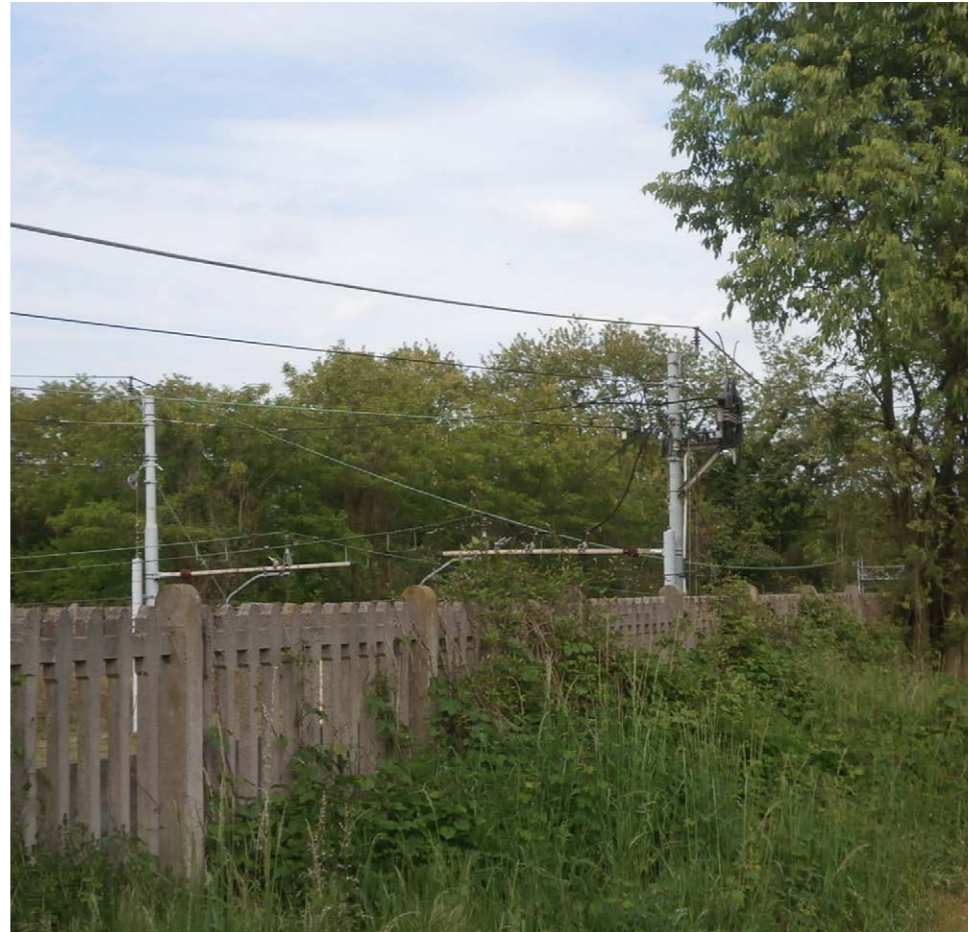
6_ Barriera in cemento a protezione della sede della metropolitana.
