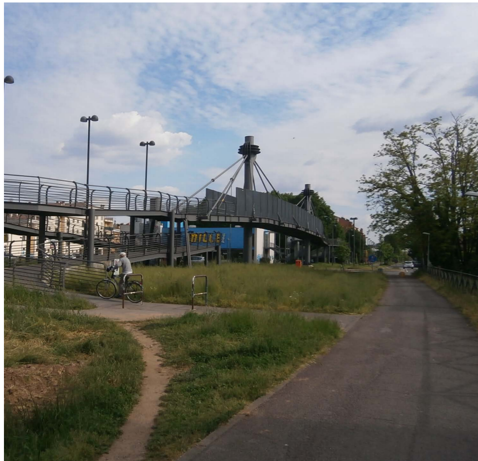
1_ Struttura per l'attraversamento ciclo-pedoanle della Statale 11.
