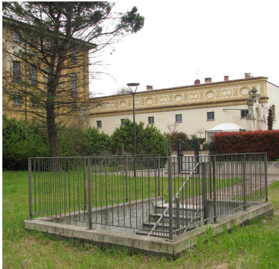
5_ Scala di accesso al parcheggio interrato.
