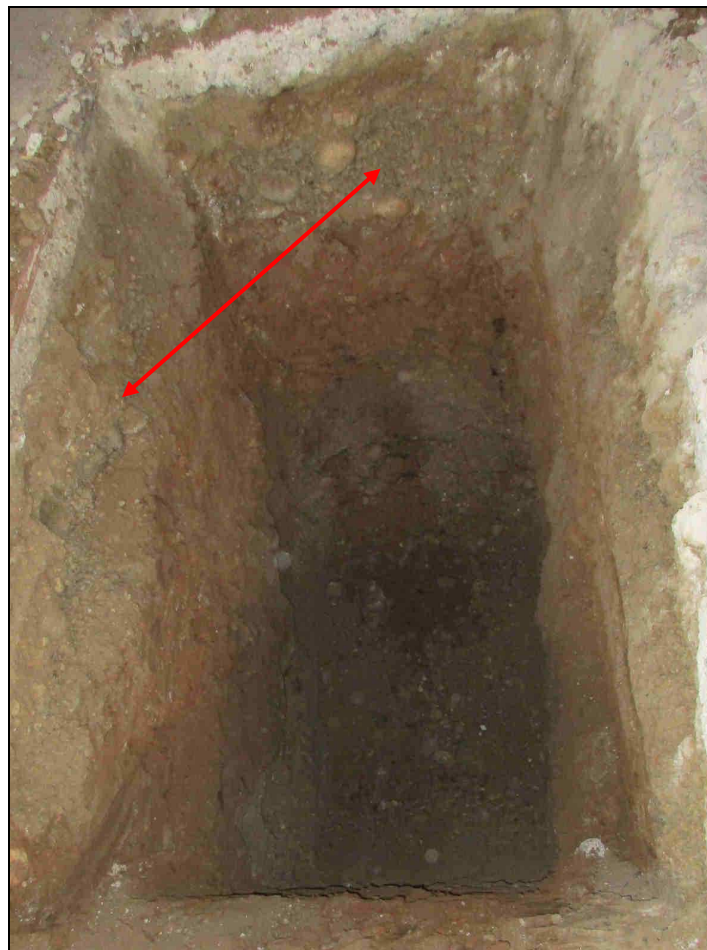
Figura 18: Riporto nella trincea T5
