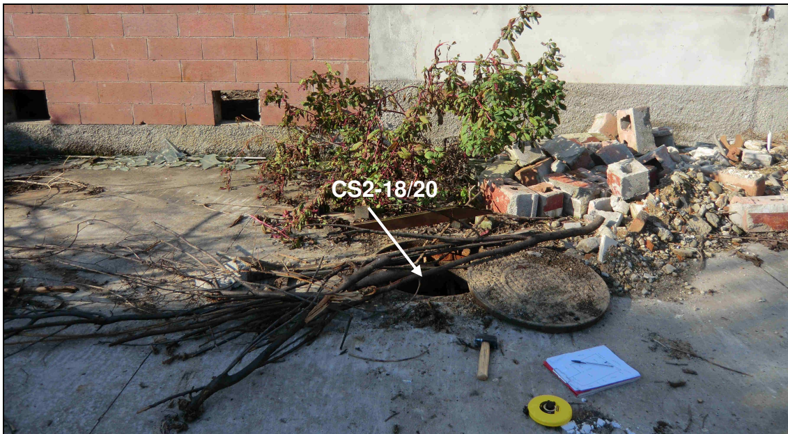
Figura 21: Serbatoio Interrato - CS2-18/20
