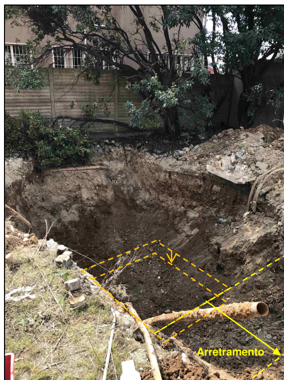
Figura 27: Asportazione materiale CS1-18/20 - parete nord e fondo scavo
