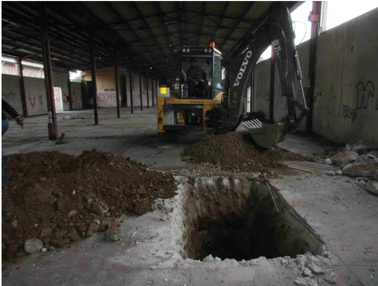
Foto 7: Esecuzione trincea T4 interno capannone via Pasubio 18/20
