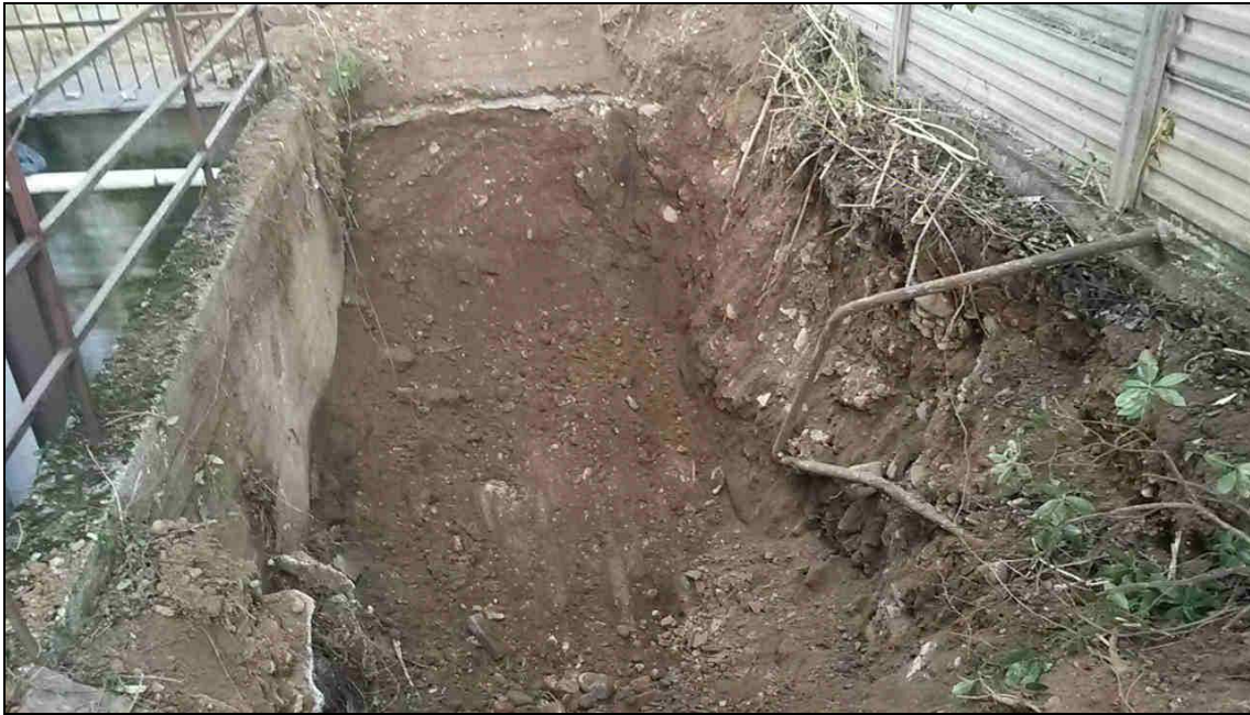
Figura 22: Scavo per l'estrazione Serbatoio CS1-16 map. 175
