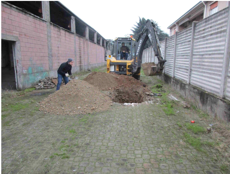
Foto 3: Esecuzione trincea corridoio nord via Pasubio 18/20
