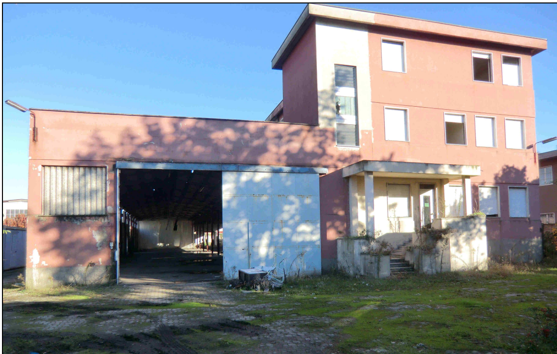
Figura 10: Accesso capannone industriale via Pasubio 18/20
