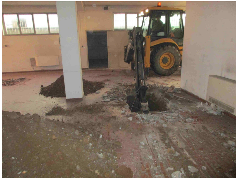
Foto 19: Esecuzione trincea T10 interno capannone via Pasubio 16 mapp 175
