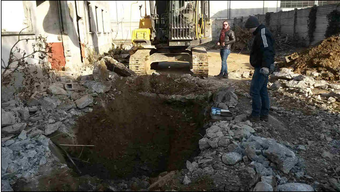
Figura 24: Scavo per l'estrazione Serbatoio CS2-18/20
