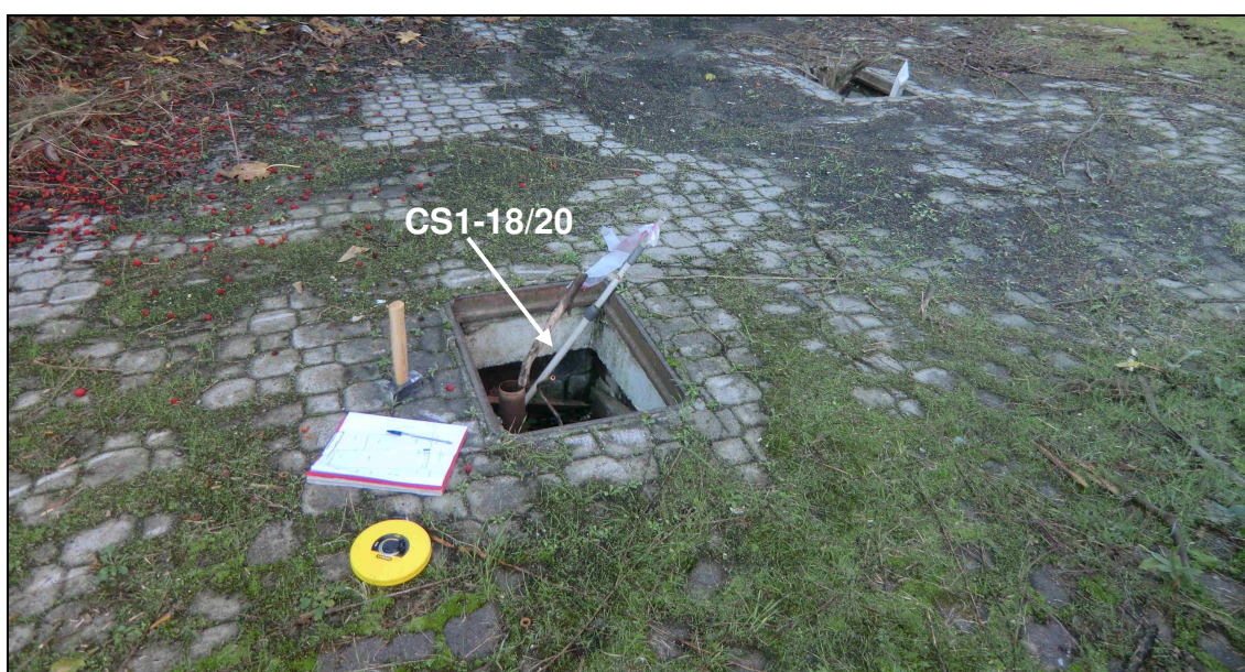
Figura 20: Serbatoio interrato - CS1-18/20
