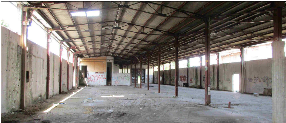
Figura 11: Vista interna capannone industriale via Pasubio 18/20
