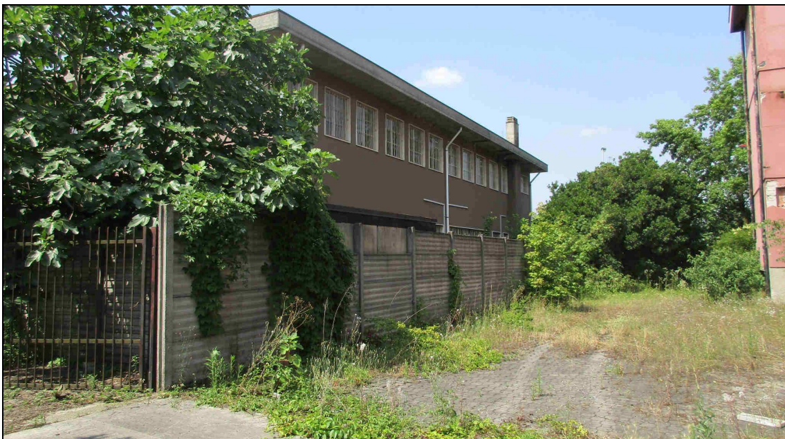
Figura 14: Vista corridoio sud “tratto con autobloccanti” - via Pasubio 18/20
