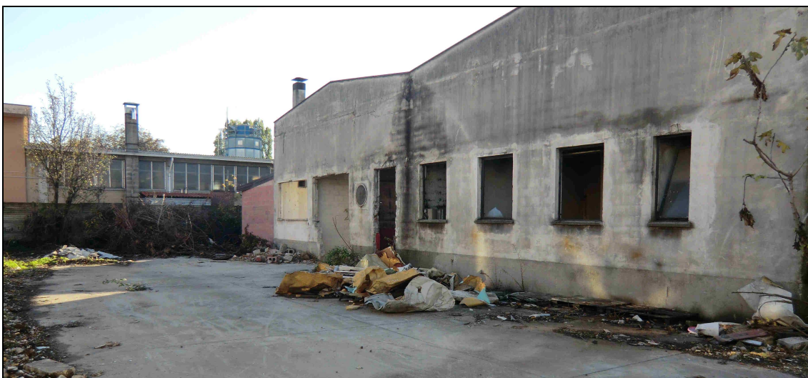
Figura 12: Vista Piazzale retro stabilimento (est) - via Pasubio 18/20
