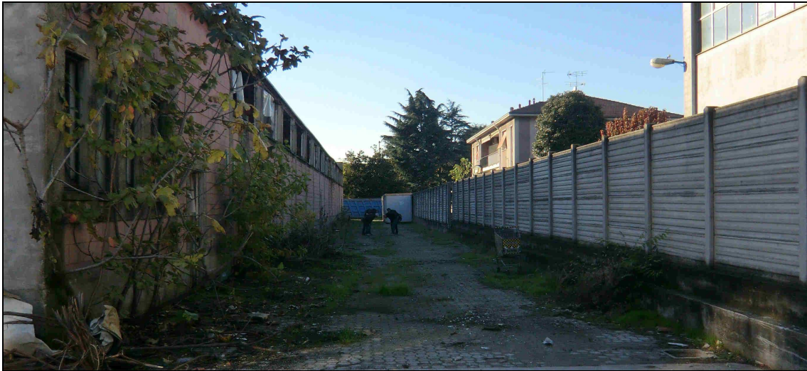
Figura 13: Vista corridoio nord - via Pasubio 18/20
