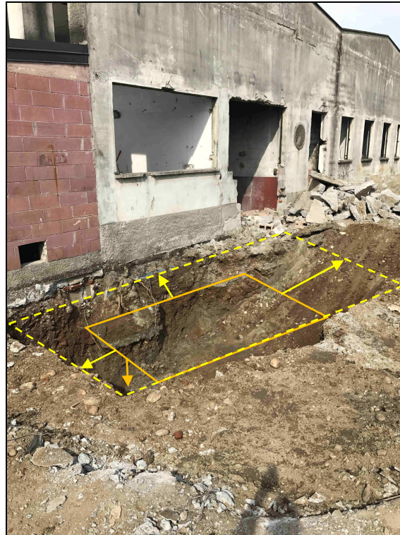
Figura 26: Asportazione materiale CS2-18/20 - Pareti Sud, Ovest, Nord e fondo scavo
