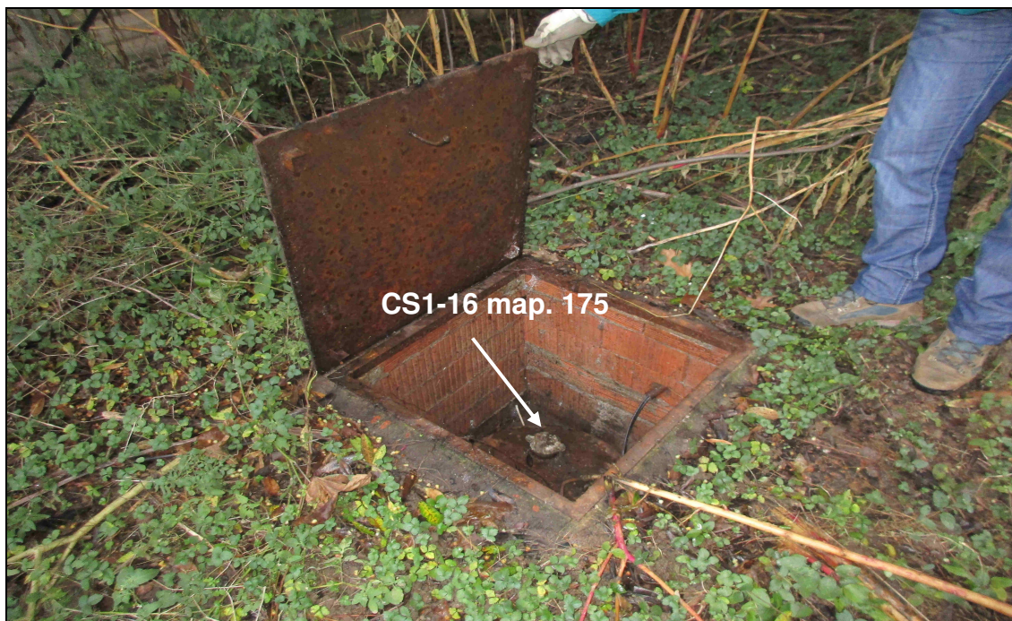
Figura 19: serbatoio interrato CS1 - 16 map. 175
