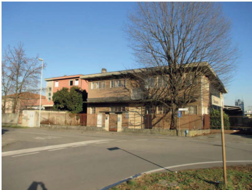
Foto 3: Stralcio via Bassano e via Pasubio e vista edificio da demolire per realizzare edifici in oggetto
