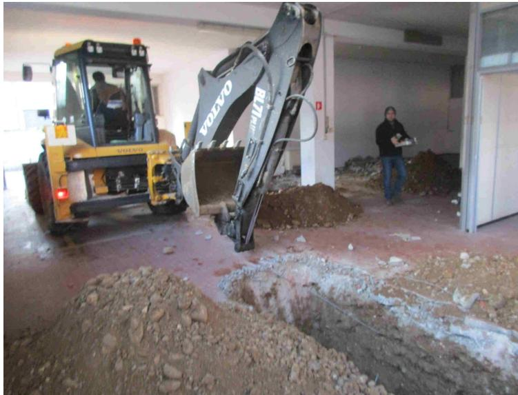
Foto 17: Esecuzione trincea T9 interno capannone via Pasubio 16 mapp 175
