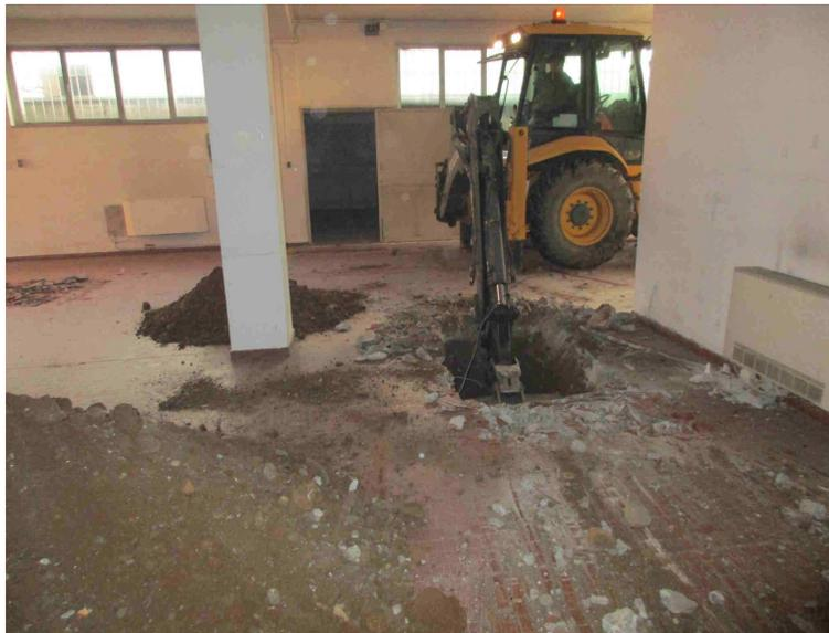
Foto 19: Esecuzione trincea T10 interno capannone via
