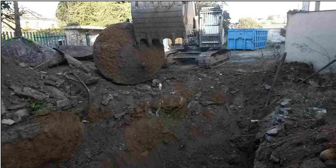
**Figura 23: Scavo per l'estrazione del Serbatoio CS1-18/20**
