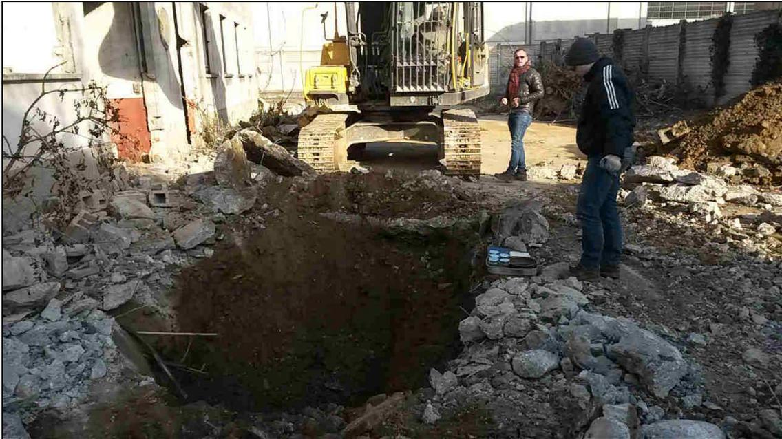
**Figura 24: Scavo per l'estrazione Serbatoio CS2-18/20**
