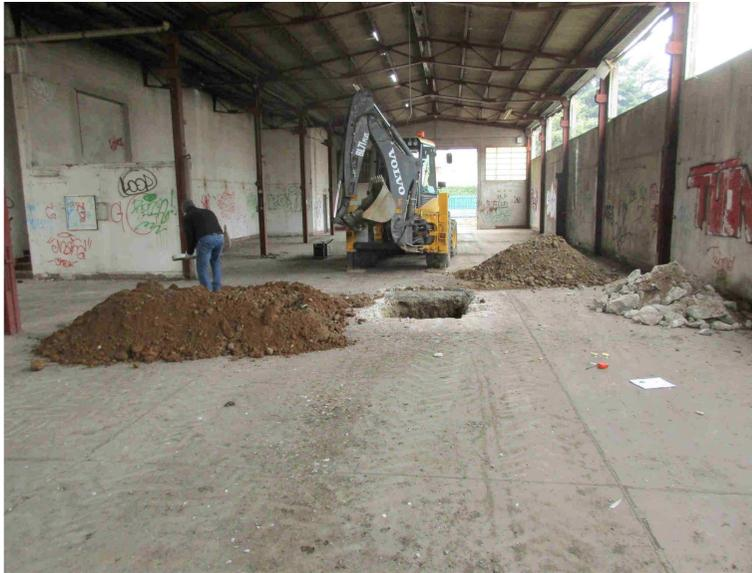
Foto 11: Esecuzione trincea T6 interno capannone via Pasubio 18/20
