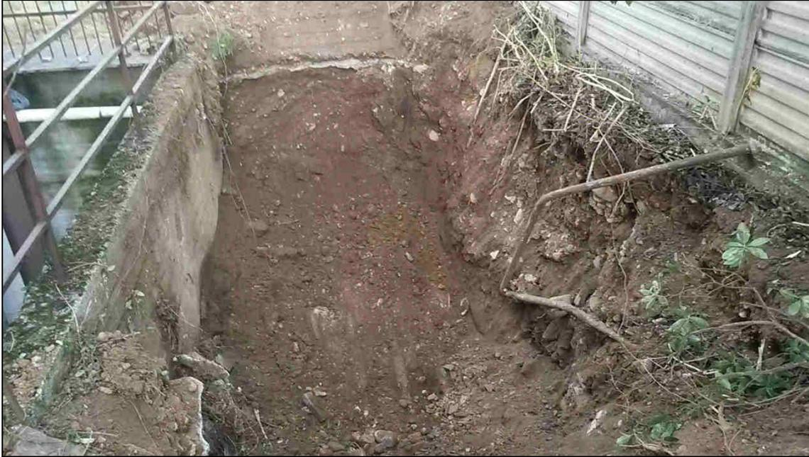
**Figura 22: Scavo per l'estrazione Serbatoio CS1-16 map. 175**
