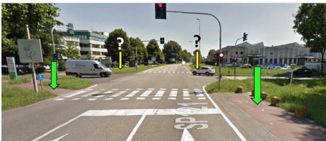
Figura 3.3.7 – Ciclopiste incomplete all'incrocio con Via Brescia
