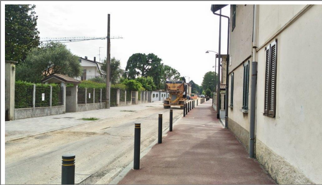
Foto 28: lavori stradali in Via Monza
