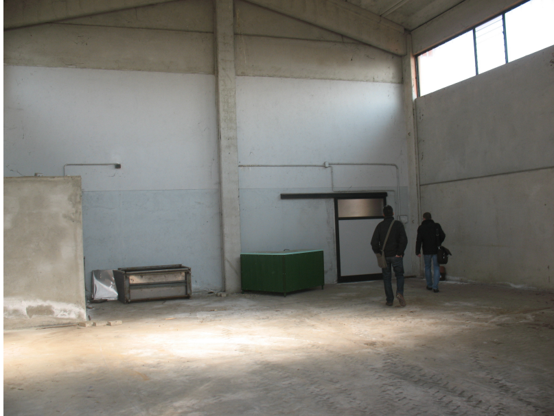
- Ripresa del magazzino -
