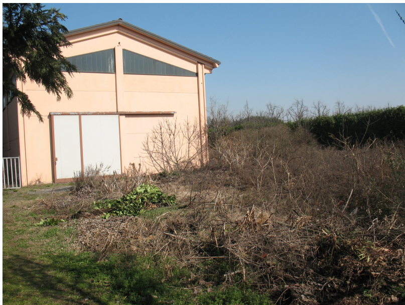
- Area esterna al magazzino di manovra mezzi -
