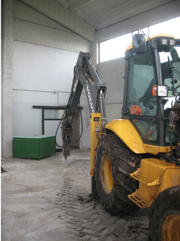
Foto 3: Demolizione della pavimentazione in calcestruzzo interna al locale magazzino preliminare all'esecuzione della trincea TR2
