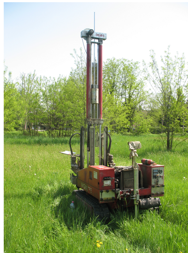
Foto 10: Ripresa dell'esecuzione dell'SCPT12
