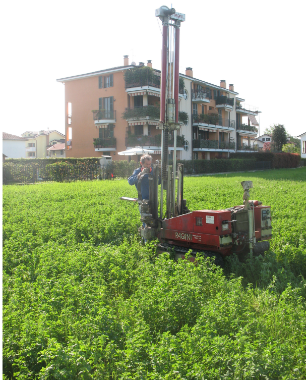
Foto 1: Ripresa dell'esecuzione dell'SCPT1
