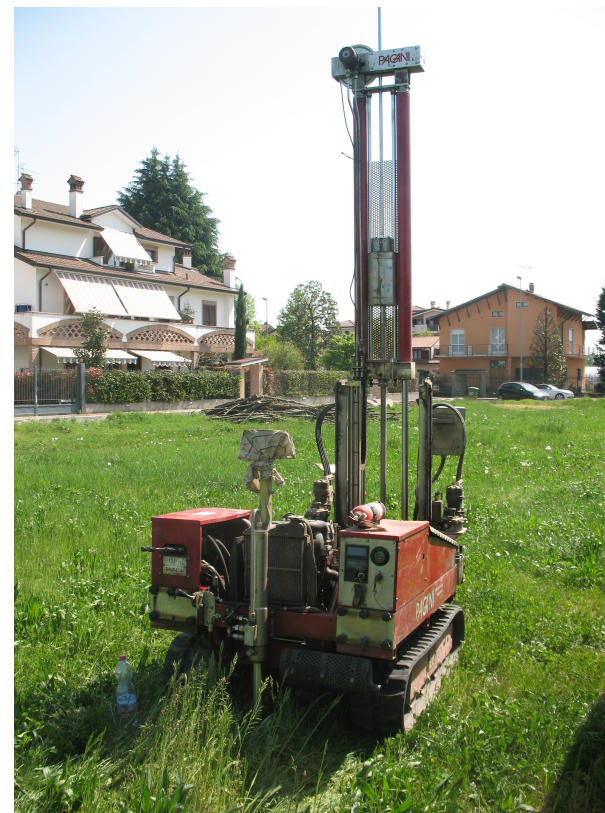
Foto 8: Ripresa dell'esecuzione dell'SCPT10
