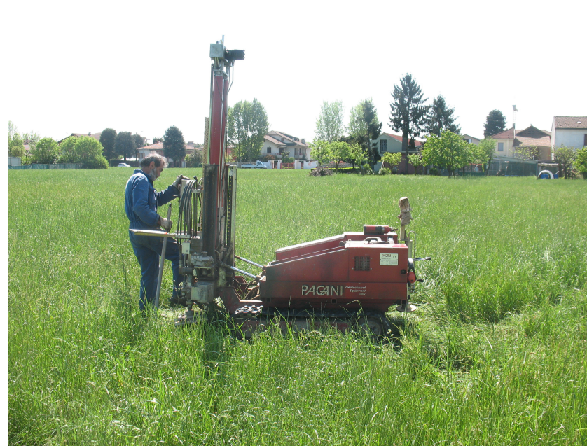
Foto 6: Ripresa dell'esecuzione dell'SCPT8
