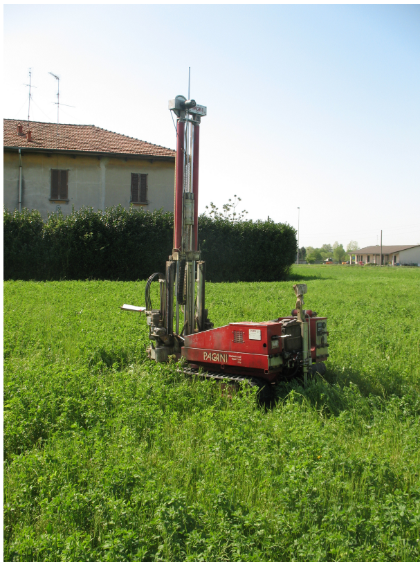
Foto 3: Ripresa dell'esecuzione dell'SCPT3
