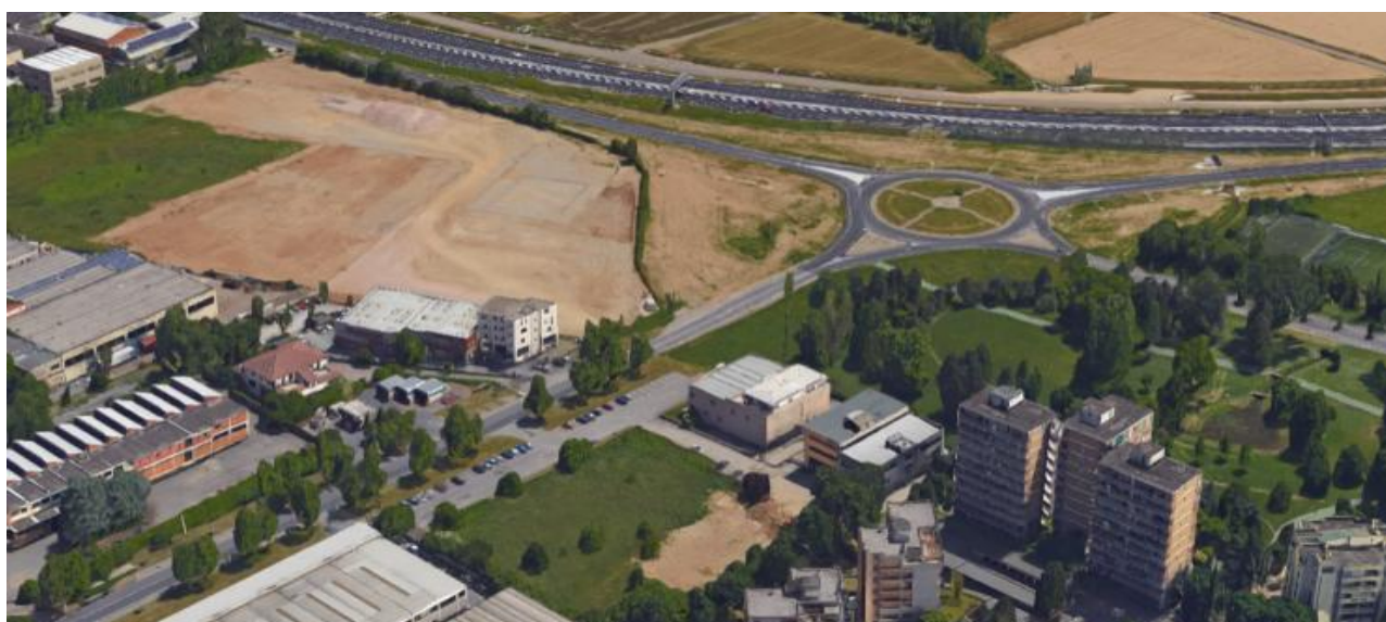
Figura 2 – Via Torino, vista aerea del campo a7_52
