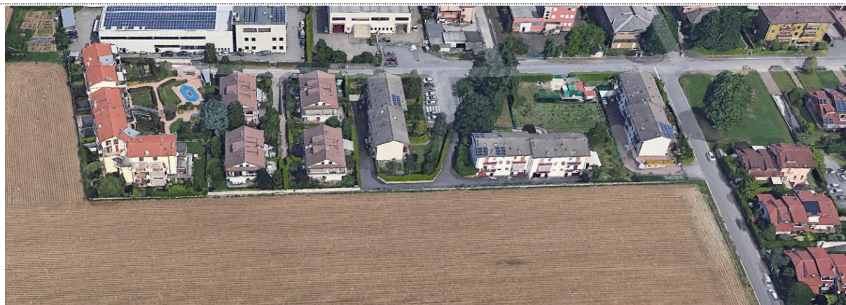
Foto aerea, il fronte edificato esistente
