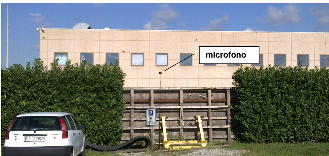
Fig. 1.VIII – Punto di misura 2 - lato via Bergamo
