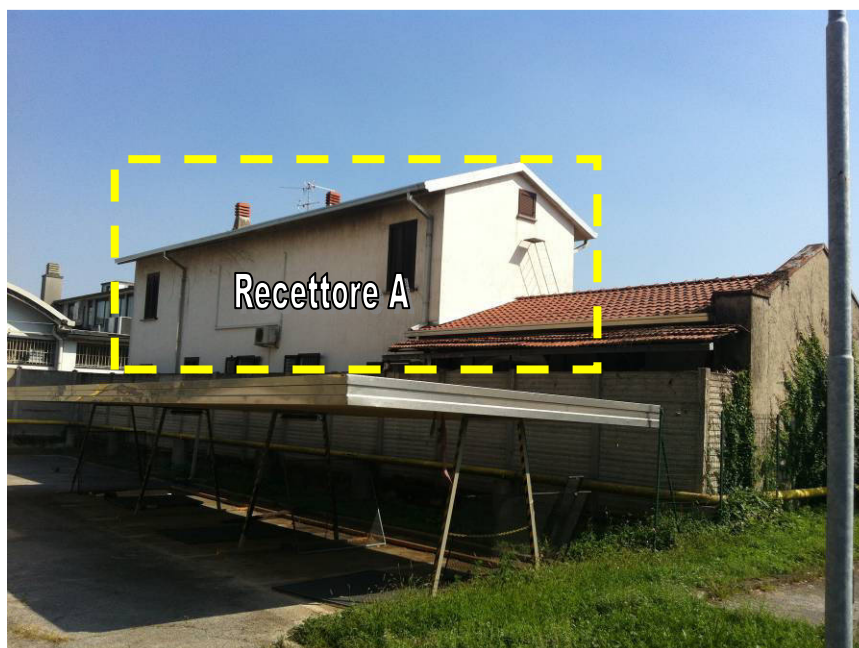
Foto 1 – Recettore A – Lato Sud-ovest
