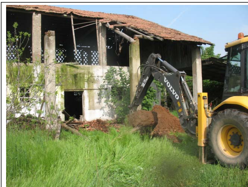
Foto 3: Ubicazione Trincea Tr2
