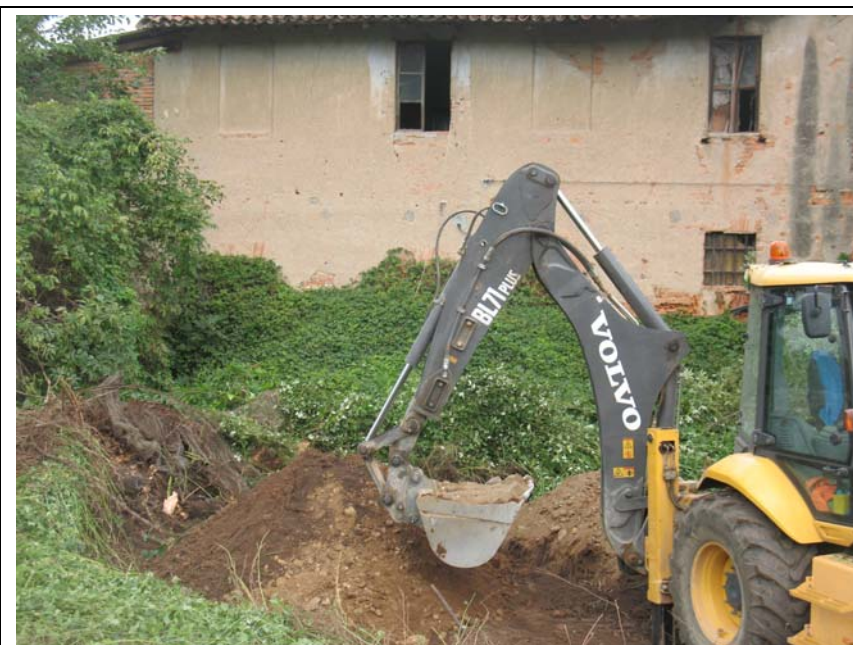
Foto 5: Ubicazione Trincea Tr8
