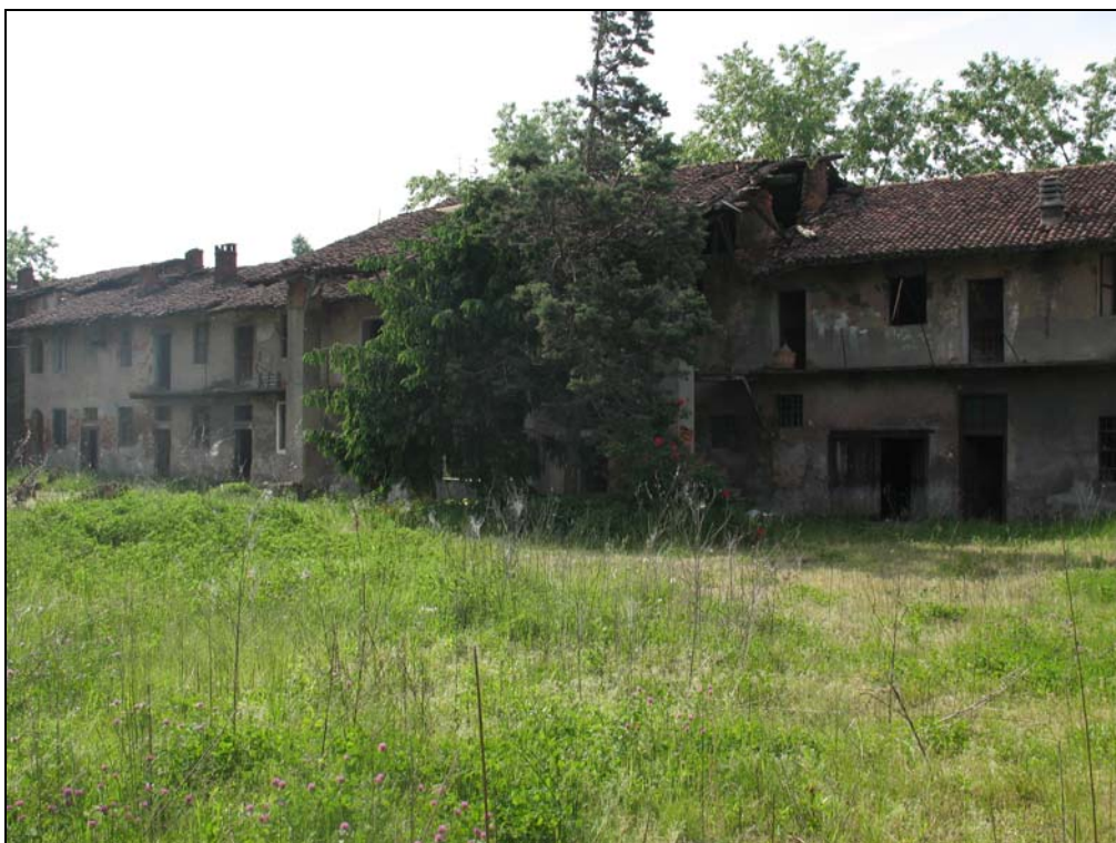
Foto 2: ala meridionale della cascina a destinazione residenziale
