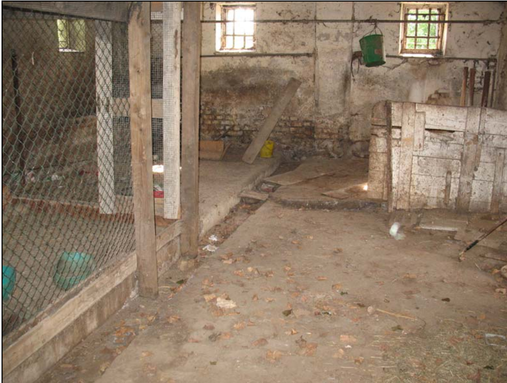
Foto 5: interni e pavimentazione delle stalle nell'ala settentrionale della cascina
