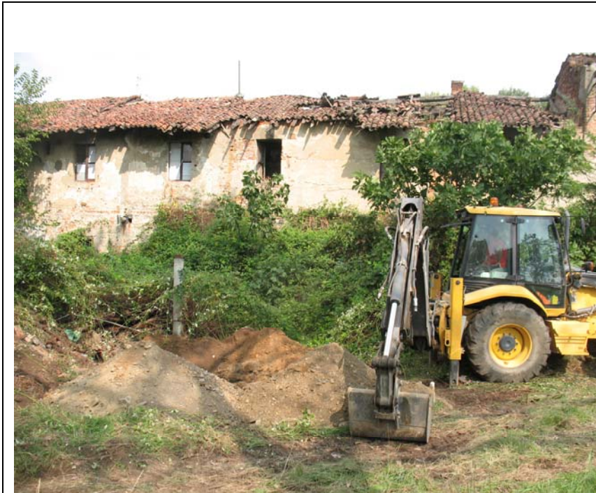
Foto 7: Ubicazione Trincea Tr9
