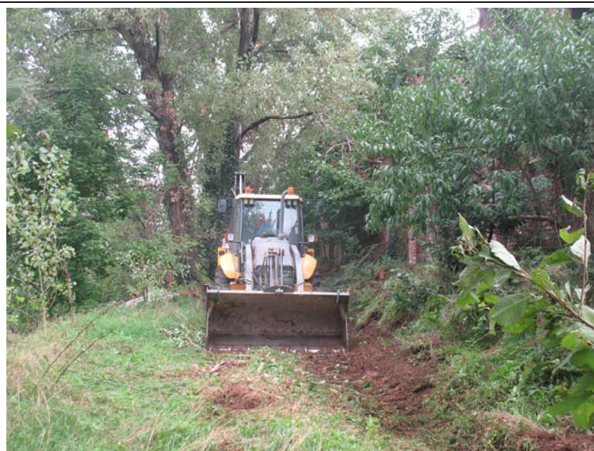
Foto 1: Ubicazione trincea Tr6
