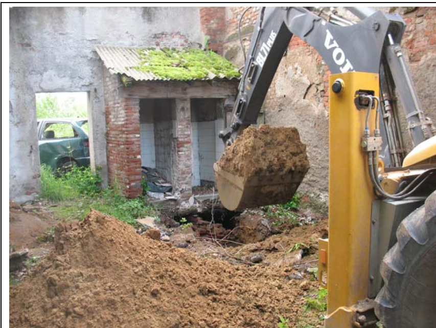
Foto 9: Ubicazione Trincea Tr5
