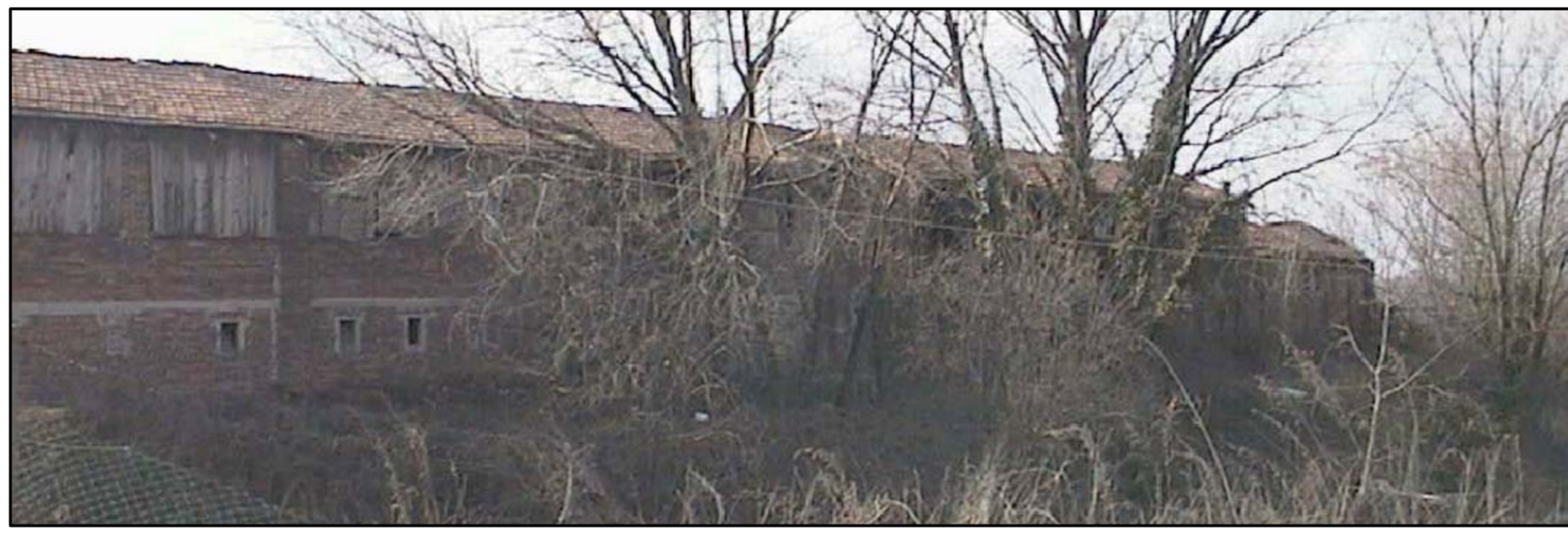
FOTO 6 - PROSPETTO ESTERNO NORD
