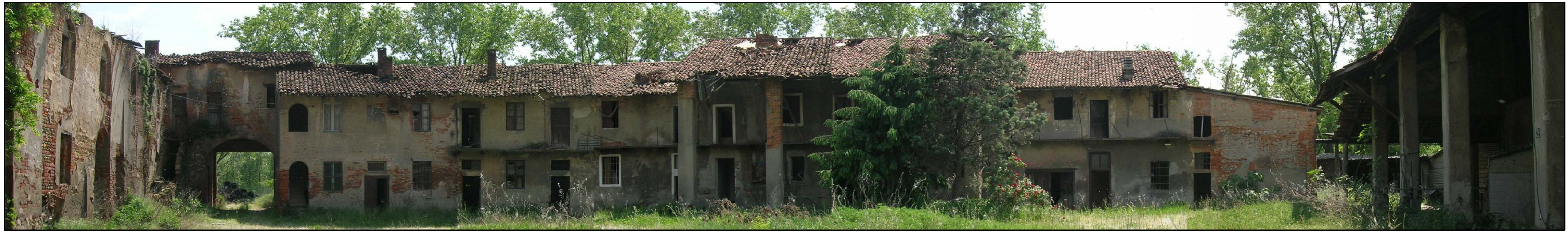
FOTO 1 - PROSPETTO INTERNO NORD
