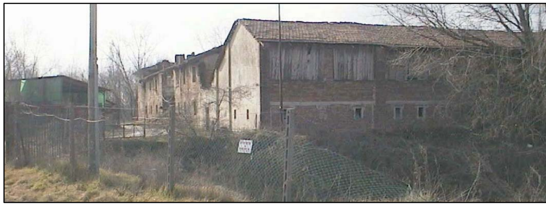
FOTO 5 - PROSPETTO ESTERNO NORD
