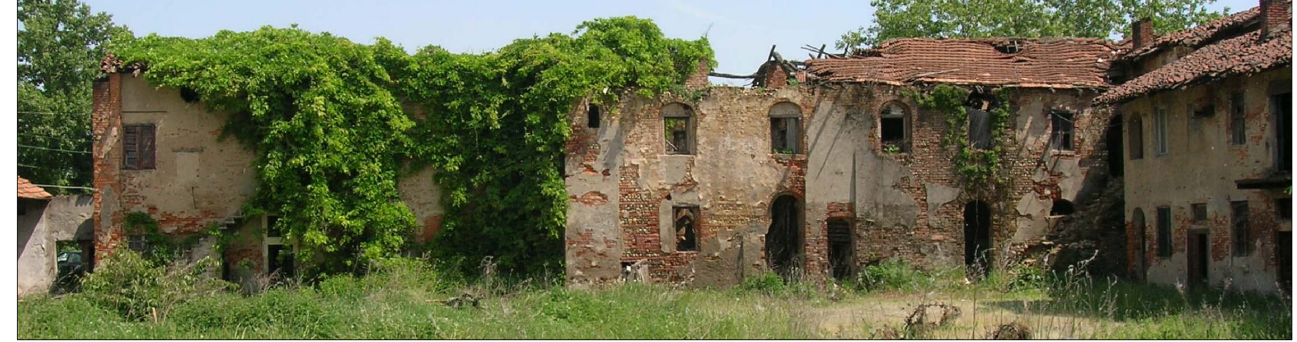
FOTO 4 - PROSPETTO INTERNO OVEST
