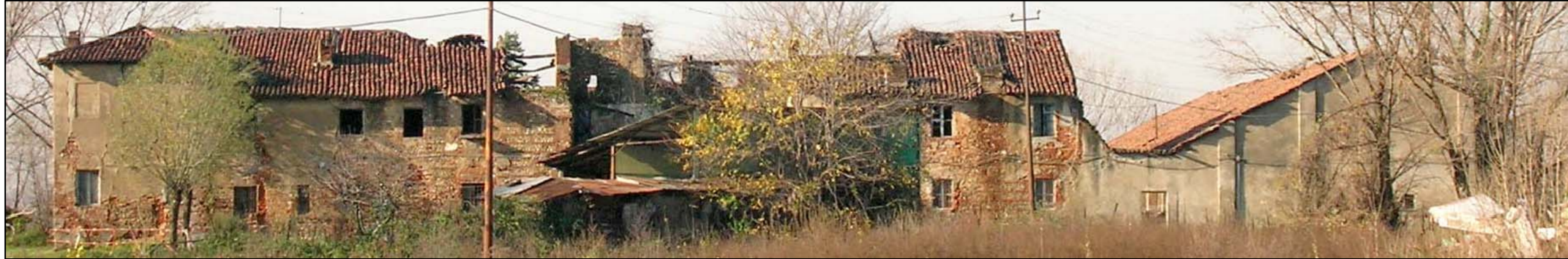
FOTO 10 - PROSPETTO ESTERNO EST
