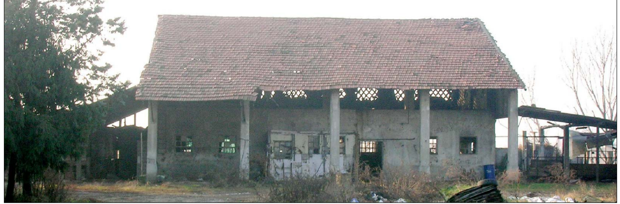
FOTO 3 - PROSPETTO INTERNO EST
